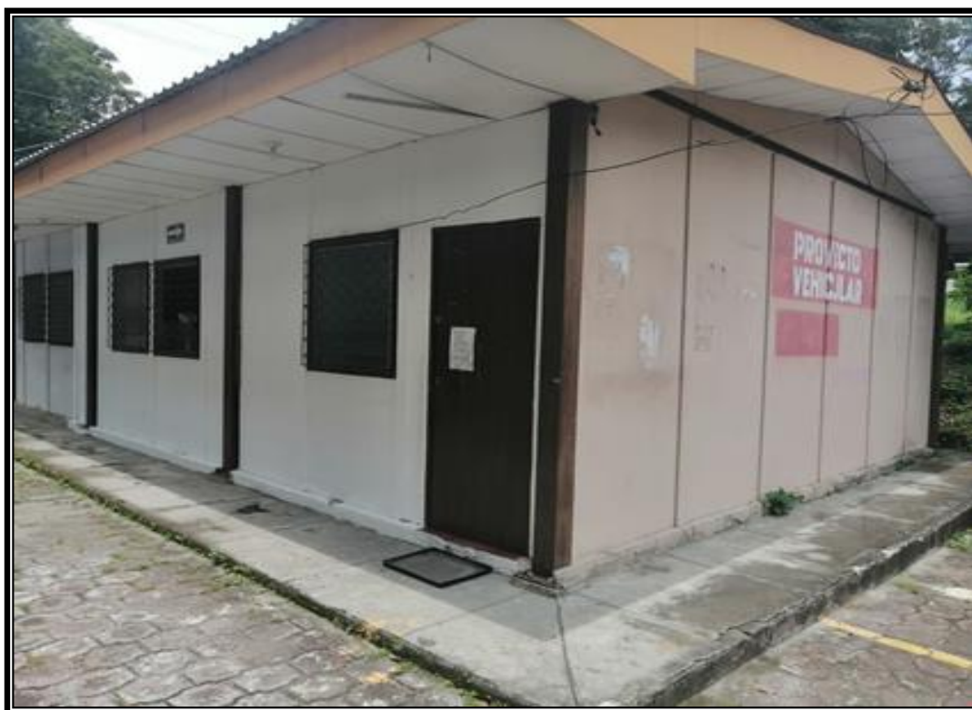
Figura N° 1: Fachada de la Unidad de Ingreso y Ordenamiento Vehicular.
