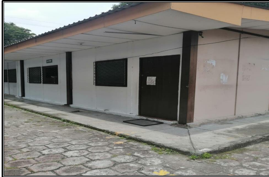
Exterior de la oficina de la Unidad de Ingreso y Ordenamiento Vehicular. Año 2021.
