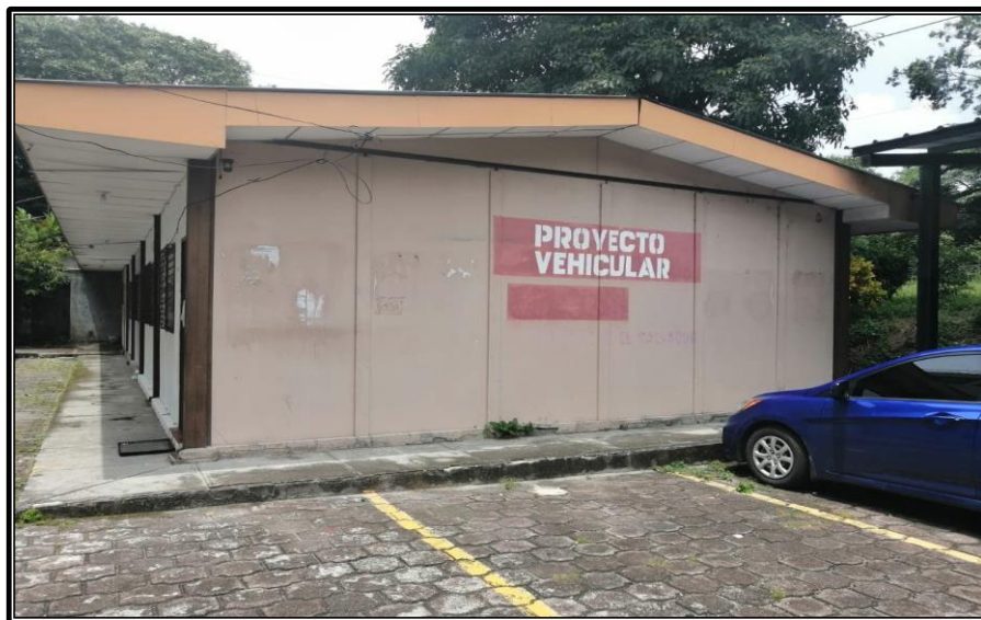
Fachada principal de Unidad de Ingreso y Ordenamiento Vehicular. Año 2021.
