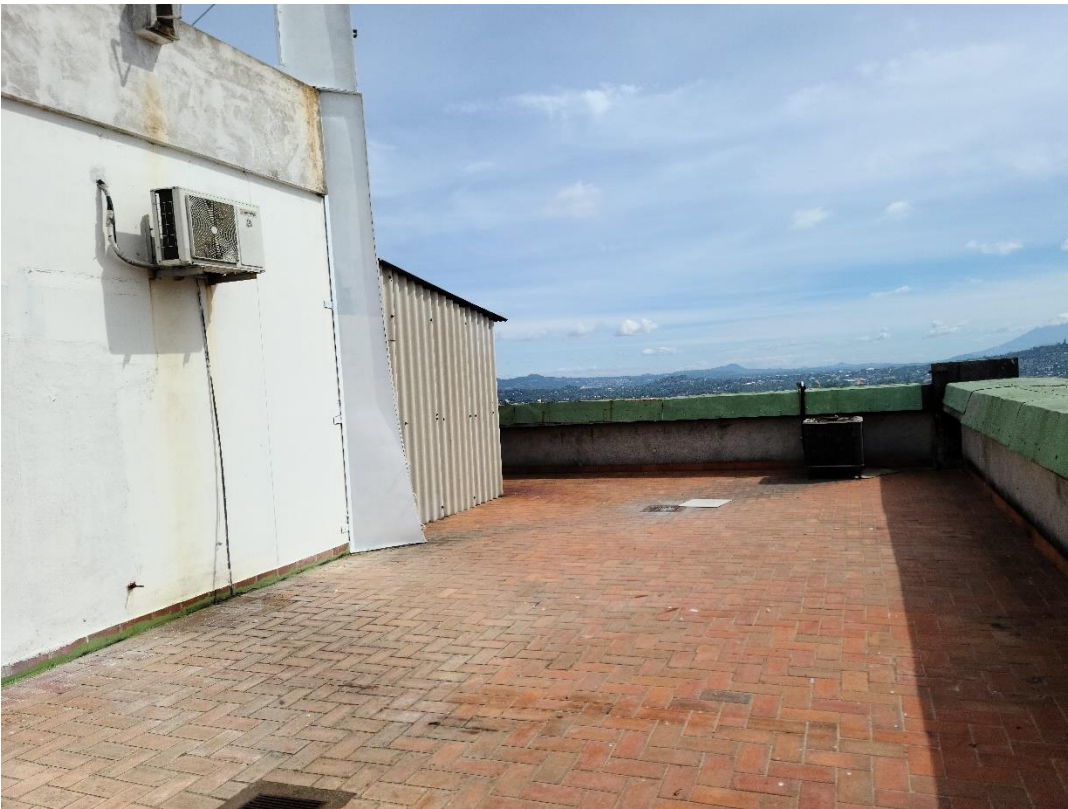
Figura 4.50 Terraza Torre PGR San Salvador, Fuente Propia.
