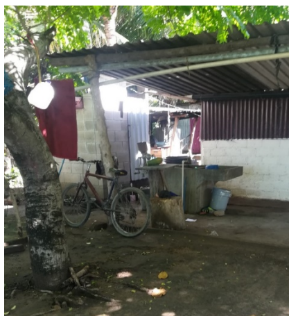
Anexo 26. Sistema de agua sin uso.
