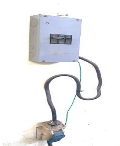
Figura 4.55 Alimentador y protección principal de la maquina universal de pruebas Hampden.
