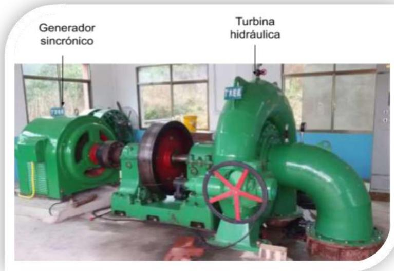
Figura 2.6 Central hidroeléctrica, sistema conformado por el acople de un generador síncrono y turbina. (De la torre, Sf)
