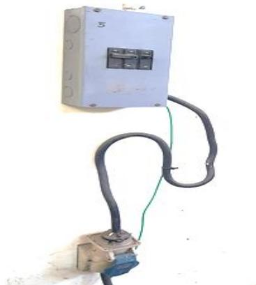
Figura 4.86 Protección principal de la maquina universal de pruebas Hampden.
