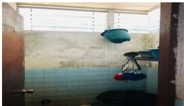
Fotografía 21: Cuarto de Limpieza.
