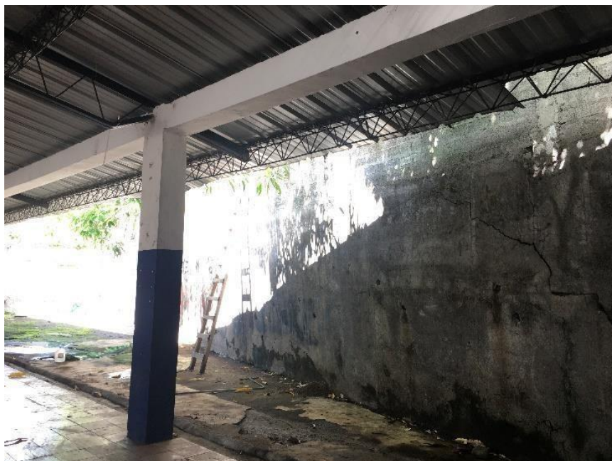
Imagen 29 fotografía del interior de la Casa Comunal en el Municipio
