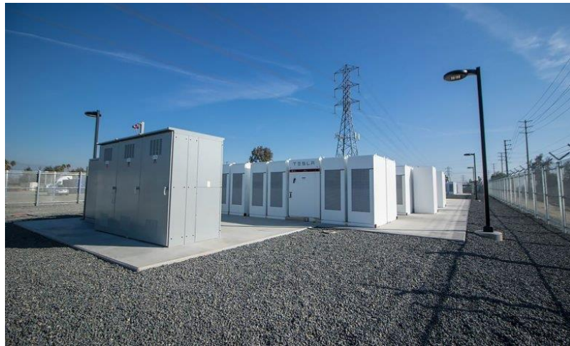
Figura 25. Sistema de almacenamiento con baterías ion-litio de Tesla, California USA[24].
