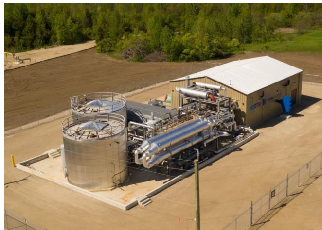
Figura 7 Sistema de almacenamiento CAES ubicado en Alabama, USA[7].
