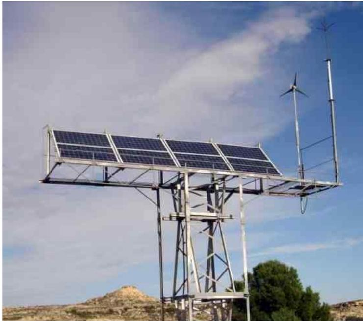
*Figura 67: Instalación de paneles solares y aerogenerador con pararrayos. Fuente: Habitissimo, instalación de placas solares, aerogenerador y pararrayos.*
