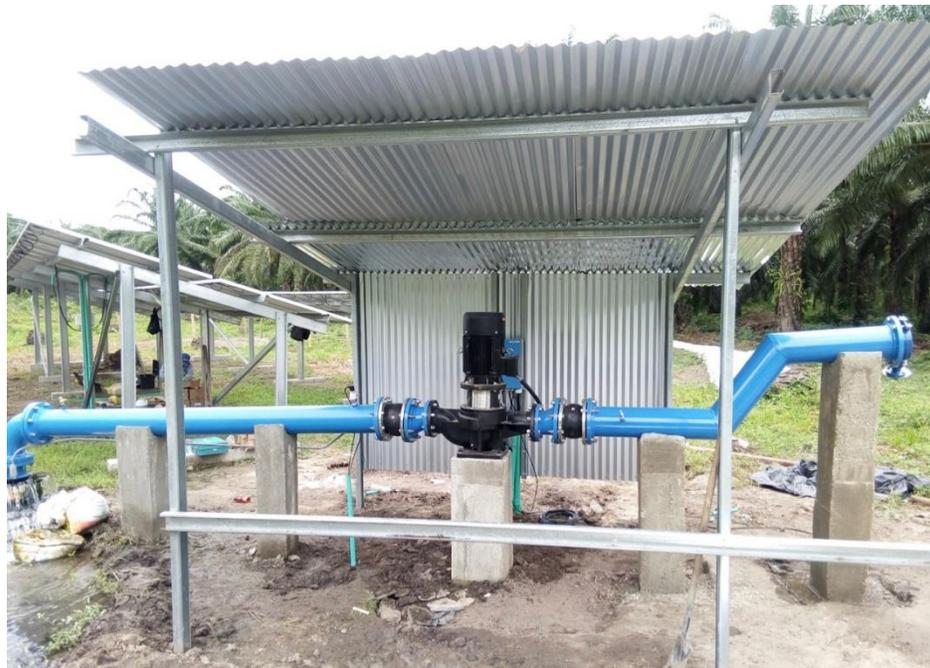
*Figura 76 Bomba superficial con paneles solares, para riego de palma, bomba de 21 Hp con caudal máximo de 80 L/s. Fuente: Energía fuera de red.*
