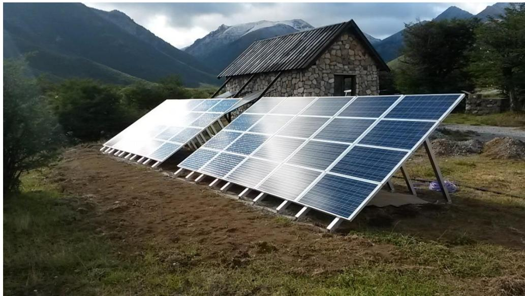
*Figura 5 Generador fotovoltaico. Fuente: SOLARTEC*
