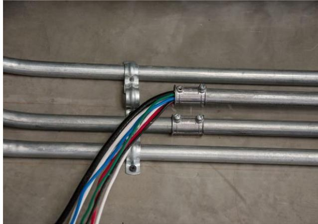
*Figura 74 Cable THHN dentro de tubería EMT Fuente: Medical Electric*
