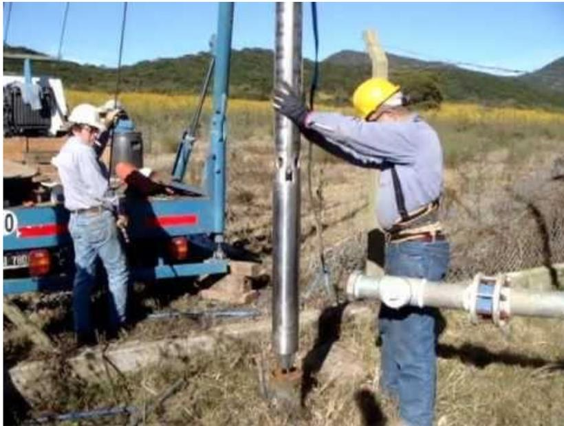
*Figura 77 Instalación de bomba sumergible Grundfos SP, Fuente: Grundfos*
