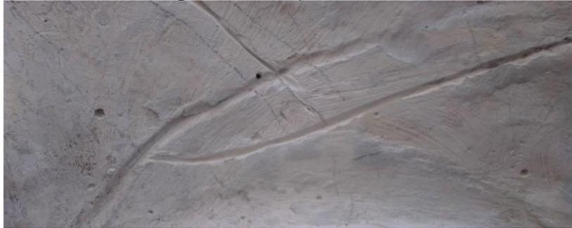
Figura 34. Detalle sisas de fisuras tratadas con herramienta rotativa Dremel, cara frontal de relieve.
