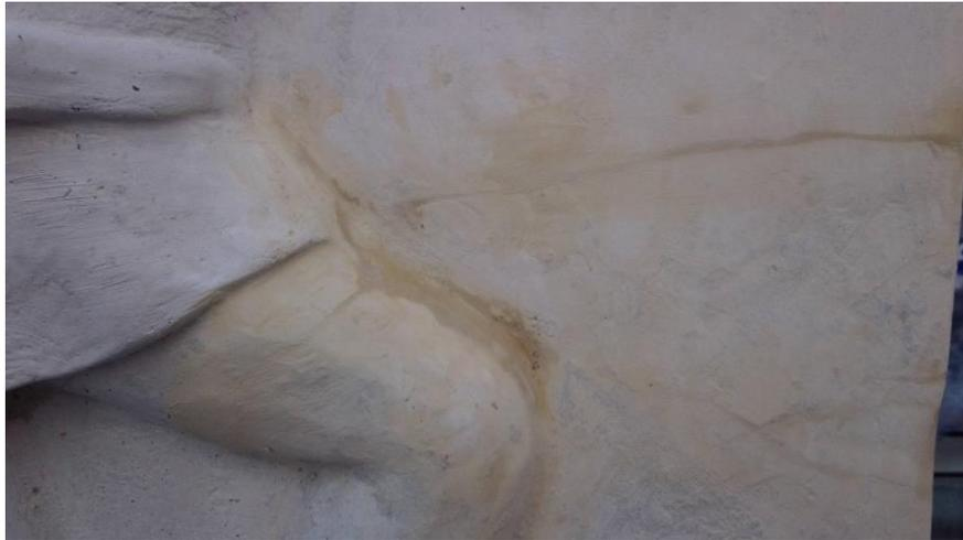
Figura 40. Detalle, resane de grieta vertical con pasta de yeso dentado, cara frontal del relieve. Fotografía tomada por: Ronny Pérez.
