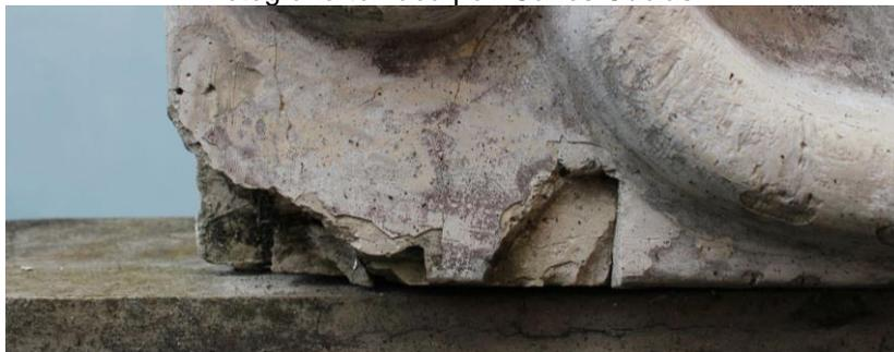
Figura 26. Desprendimiento de material, ubicado en cara frontal inferior del relieve.
