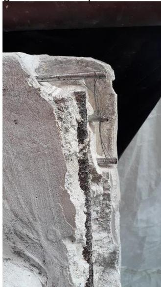
Figura 35. Detalle instalación de pines metálicos para refuerzo de material, lado derecho frontal del relieve.
