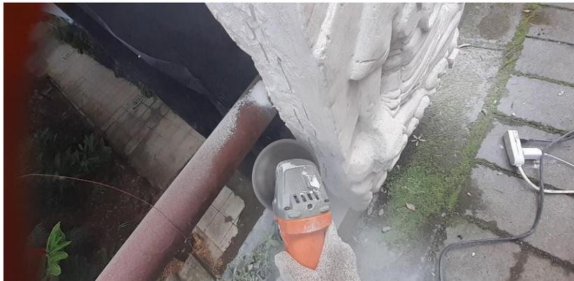
Figura 31. Uso de esmeril angular para el trazado general de sisas en lado izquierdo del relieve.
