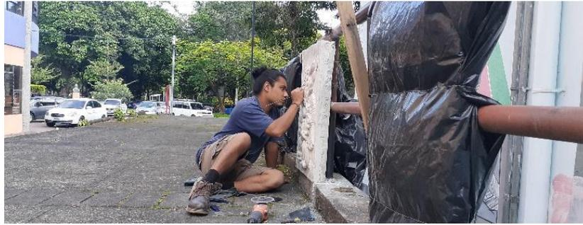
Figura 30. Detalle, uso de punzones planos para retirar capas de pinturas y resanes.
