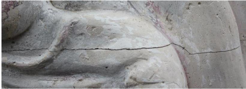
Figura 24. Detalle de grieta, lineal horizontal ubicada en cara frontal del relieve.
