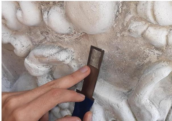
Figura 28. Detalle, uso de espátula para retirar capas de pintura en relieves.
