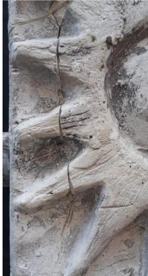
Figura 38. Detalle de grieta vertical cara frontal del relieve.
