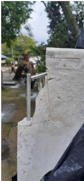
Figura 108: registro fotográfico, instalación de pines metálicos, vista frontal 2022.
