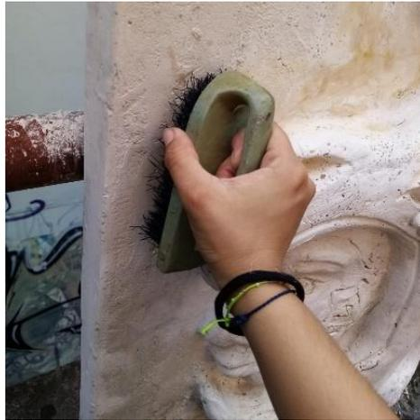
Figura 47. Proceso de lavado, uso de cepillo húmedo para retirar polvo, previo a su aplicación de impermeabilizador blanco.
