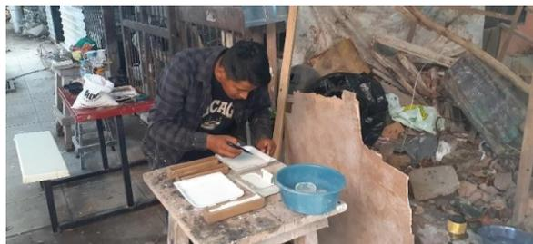
Figura 15. Práctica, formulación de diferentes tipos de pastas (yeso calcinado, cemento blanco, chispa y polvo de mármol), para aplicación final.
