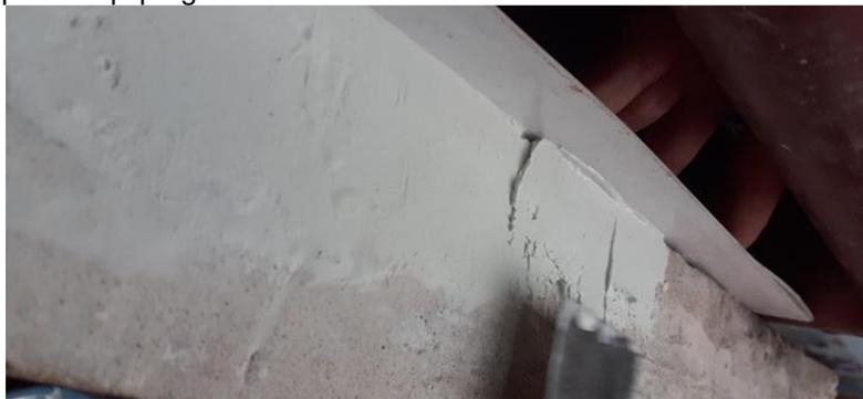
Figura 114: registro fotográfico aplicación de mezcla para resanado de laterales, vista en picada 2022.
