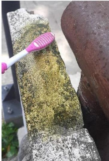
Figura 13. Relieve N°1, Prueba de lavado, utilizando mezcla de alcohol y agua, para tratar las causas del deterioro de carácter biológico y químico.
