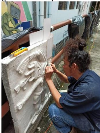
Figura 36. Detalle, instalación de cimbras para el proceso de vaciado y reconstrucción de partes faltantes del relieve.
