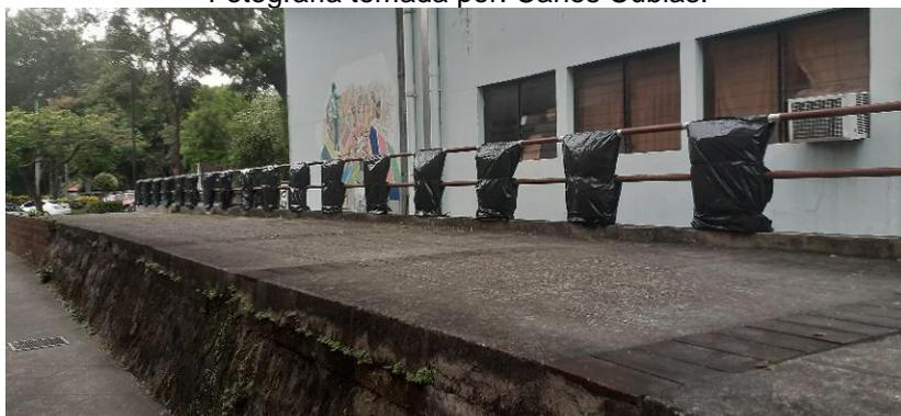
Figura 27. Protección de relieves de forma individual, para evitar acumulación de humedad y evitar mayor deterioro.
