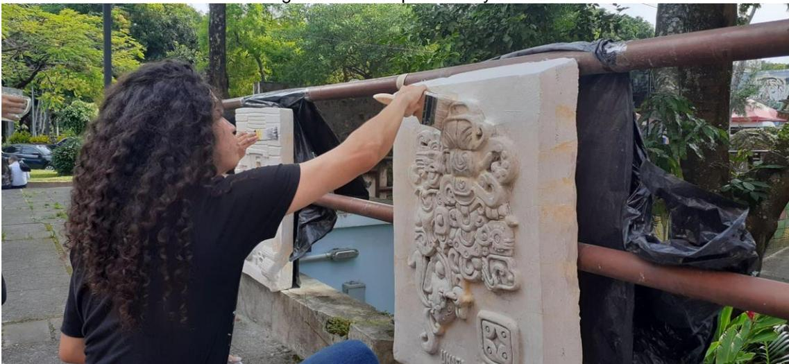
Figura 49. Proceso de aplicación de impermeabilizante aqualock blanco.
