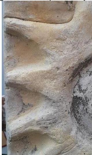
Figura 39. Detalle, resane de grieta vertical con pasta de yeso dentado, cara frontal del relieve.
