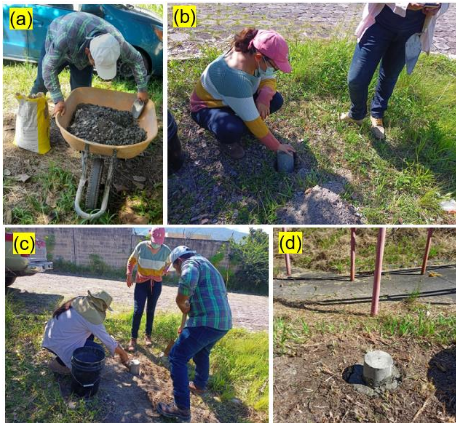
Figura 26. (a) Elaboración del concreto. (b) Colocación del mojón en la excavación. (c) Colocación de concreto alrededor del mojón. (d) Mojón recubierto hasta nivel de suelo.
