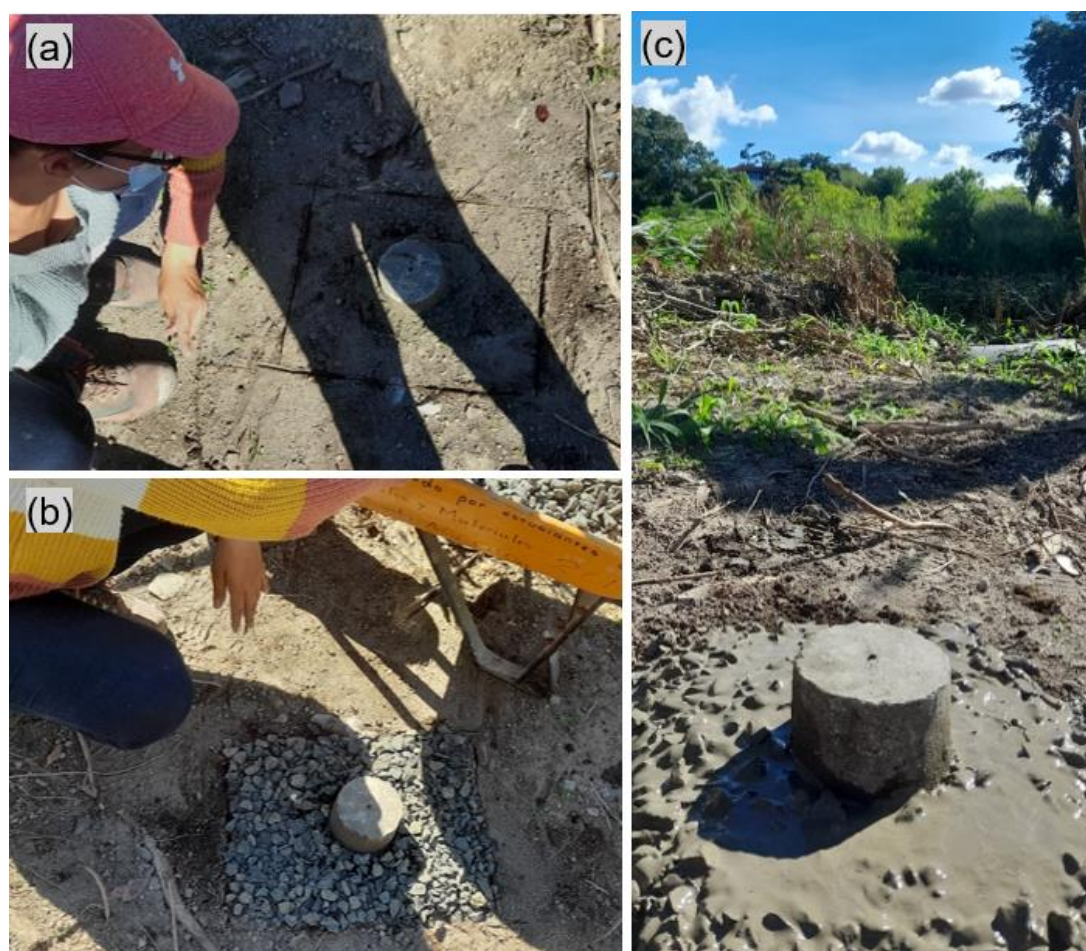
Figura 34. (a) Trazo de forma para colocación de grava (b) Grava colocada para protección del punto (c) Colocación de lechada sobre grava para mayor adherencia.
