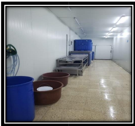
Figura 20. Área de recepción.
