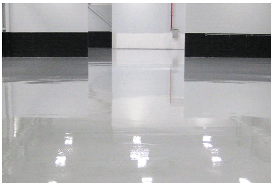
Figura N°2. Piso con resina epóxica.
