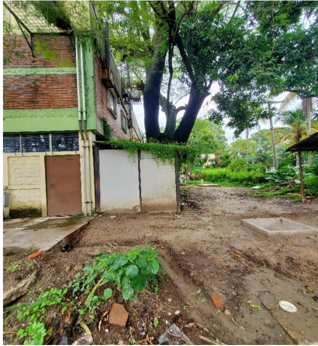
Figura N°31. Riesgo físico natural de aula de discusión de farmacología.
