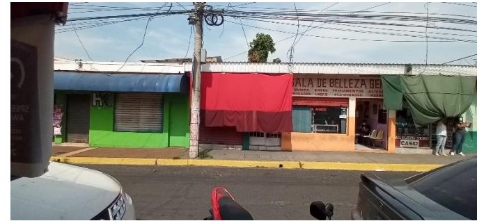
Figura 84. Fachadas ocultas por toldos o telas como medida improvisada para la protección solar. Algunas fachadas se han remplazado por cortinas metálicas.
