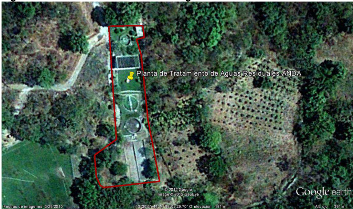
Figura A – 1. Planta de Tratamiento de Aguas residuales ANDA.
