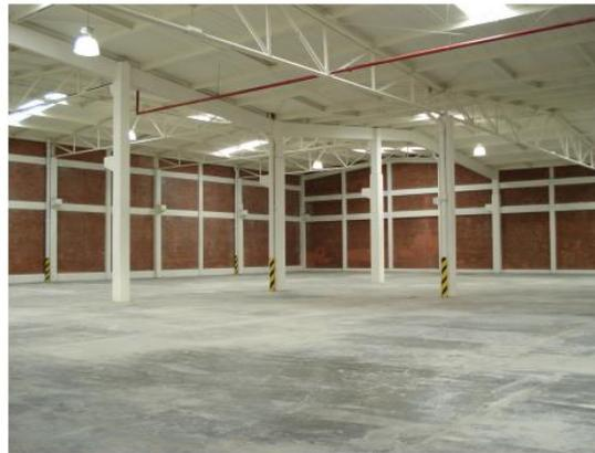
Fig. 1.2 .- Nave industrial de marcos compuestos por armaduras y columnas.<sup>2</sup>
