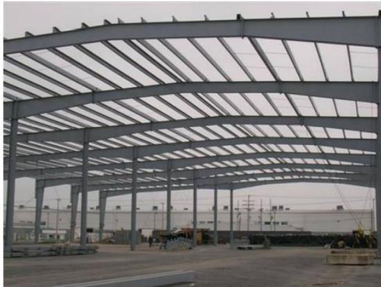
Fig. 1.1.- Nave industrial de marco rígido con sección variable.<sup>1</sup>
