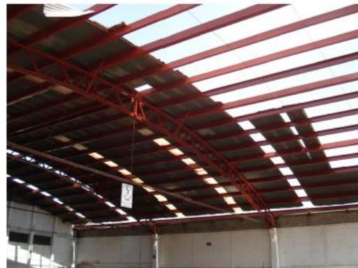
Fig. 1.3 .- Nave industrial de marcos compuestos por arcos y columnas.<sup>3</sup>
