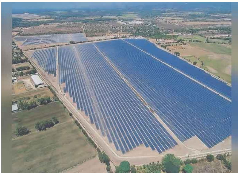
Figura 1.13 Centrales o plantas fotovoltaicas.
