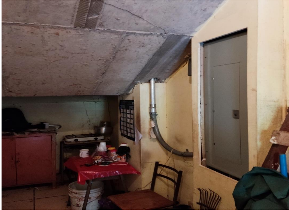
Figura J.24 Cuarto de inversores edificio N
