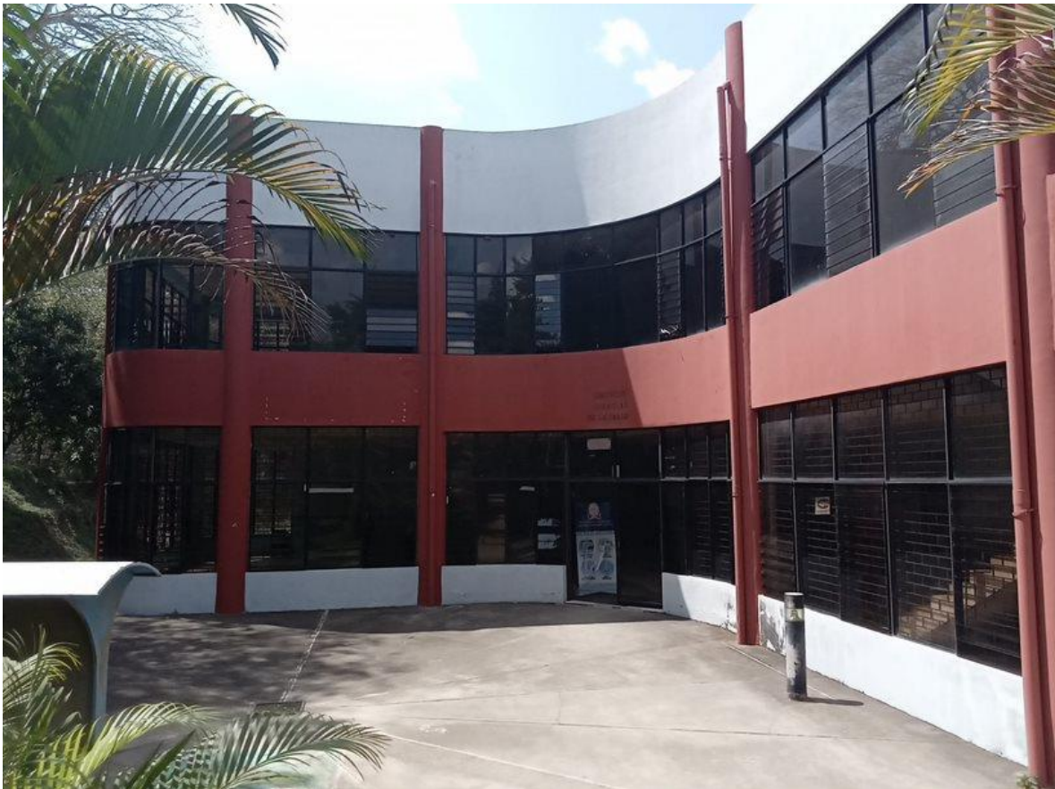
Figura J.14 Edificio de Medicina
