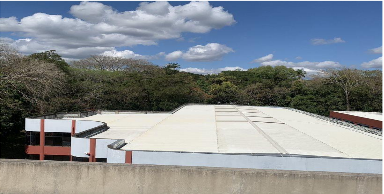
Figura J.15 Área de techos 1 edificio de Medicina
