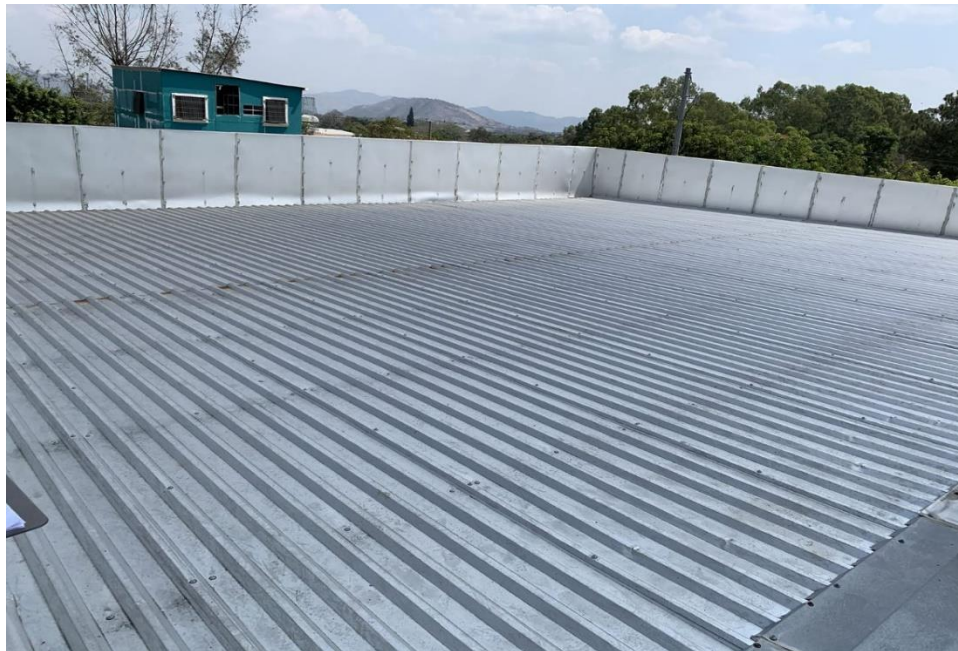
Figura J.3 Área disponible sobre el techo del edificio de Deportes
