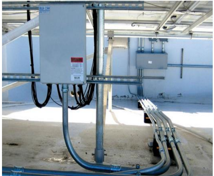
Figura 1.19 Canalización de conductores en tubería metálica
