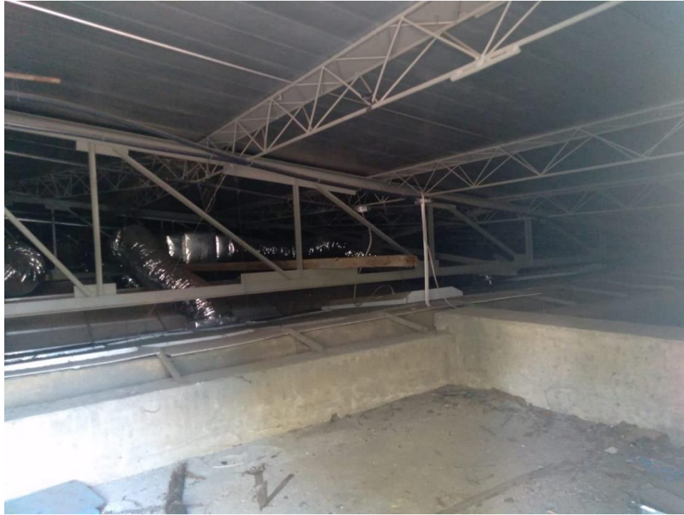
Figura J.32 Estructura de soporte del techo Auditórium
