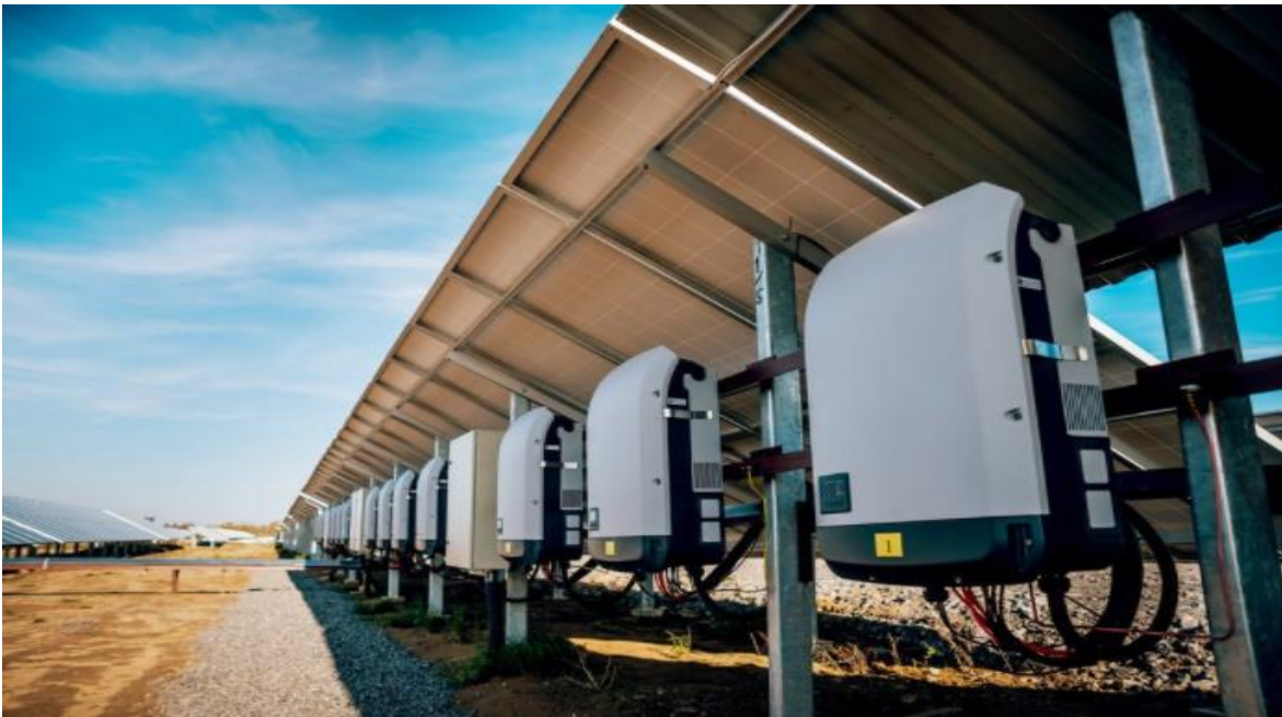
Figura 1.15 Inversores en un sistema fotovoltaico
