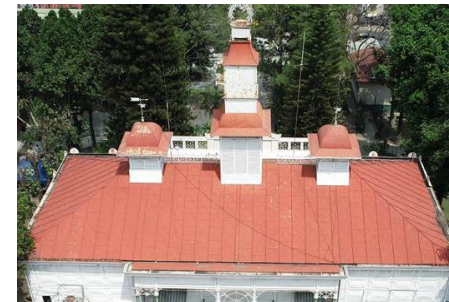
Fotografía 20. Techo Edificio Principal.
