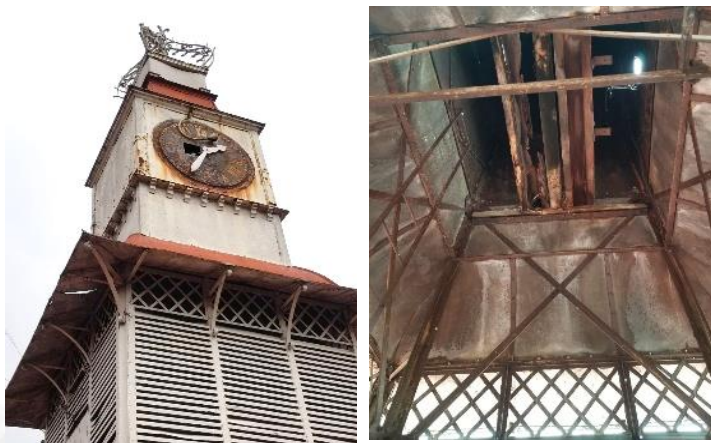
Fotografía 23. Elementos estructurales metálicos torre principal.
