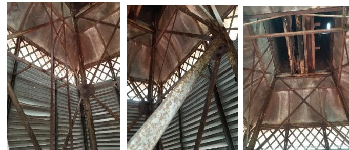
Fotografía 34. Estructura interna de torre principal.
