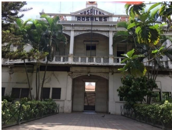
Fotografía 19. Fachada norte, Edificio Principal.
