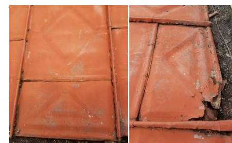
Fotografía 21. Decoloración y deformación de láminas.
