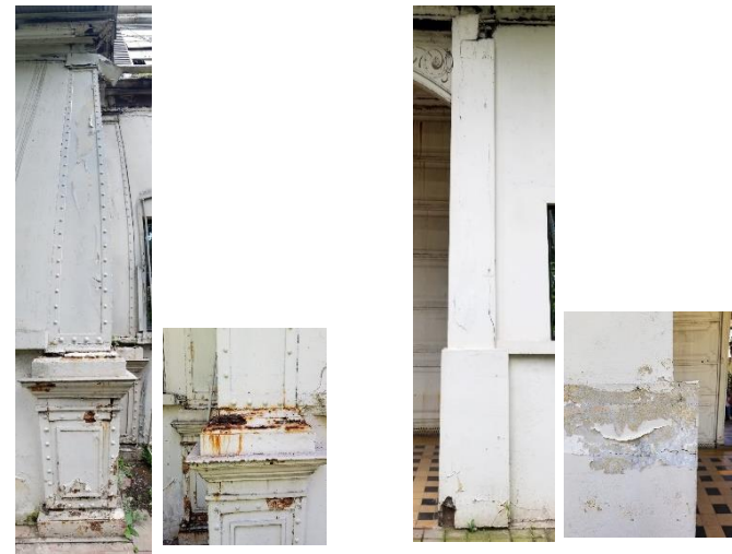
Fotografía 32. Columnas externas de acero y de concreto primer nivel.
