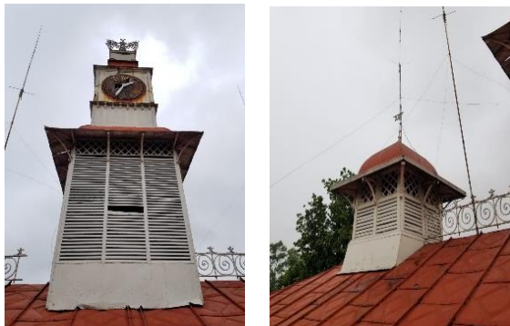
Fotografía 33. Torre principal y torre lateral.
