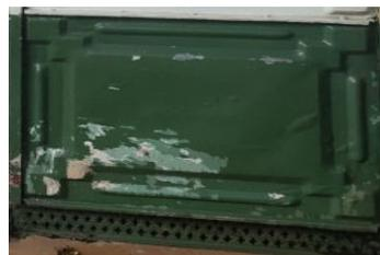
Fotografías 53: Detalles de piezas de lámina con daños de pintura.
