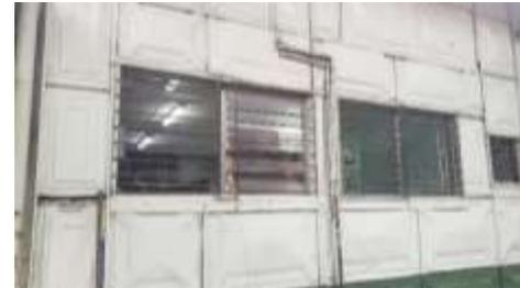
Fotografías 56: Detalle de paredes con piezas de láminas troquelada faltante.
