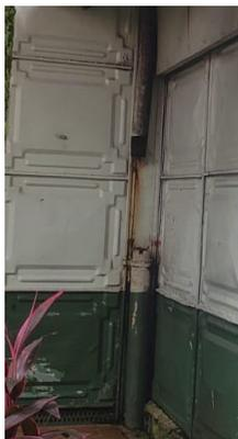
Fotografías 52: Detalles de piezas de lamina troquelada con problemas de oxidación.
