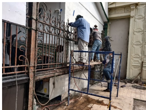
Foto 28 Reparación del tramo #11
