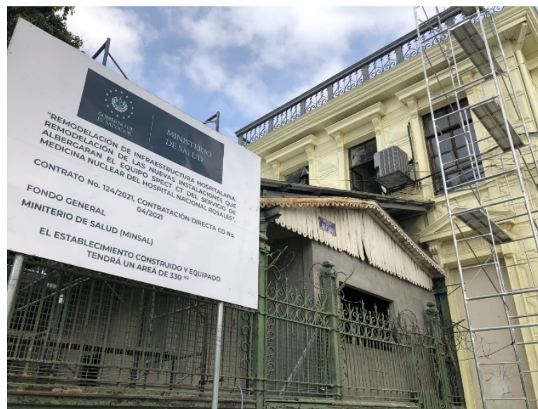
Foto 23 Vista Actual de la Puerta 2 Ubicada al Norte del Barandal
