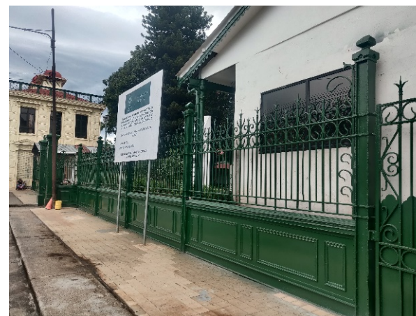
Foto 30 Vista general del Barandal ya finalizada la intervención
