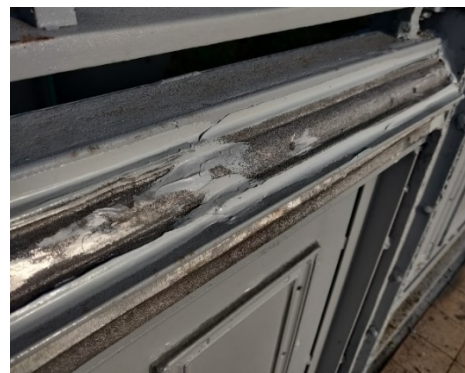
Foto 16 Parte central con aplicación de masilla plástica
