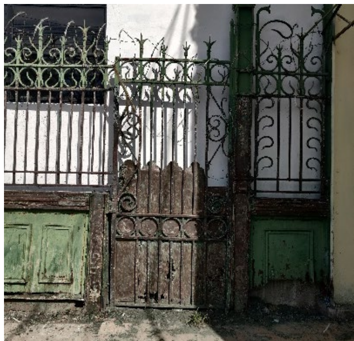
Foto 14 Puerta 2 del Barandal Hospital Rosales
