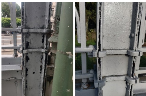
Foto 22 Columna tipo 1 ya intervenida con dos capas de pintura
