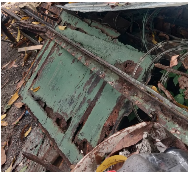
Foto 17 Estado de deterioro de los elementos retirados
