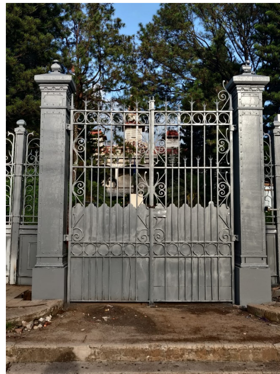
Foto 26 Portón principal ya intervenido
