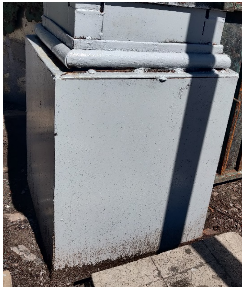
Foto 24 Resultado de la intervención en las bases de las columnas tipo 1
