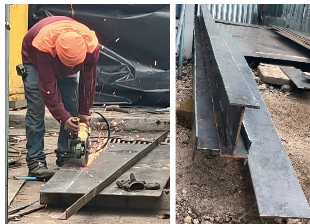
Foto 19 Corte y realización del perfil "I"
