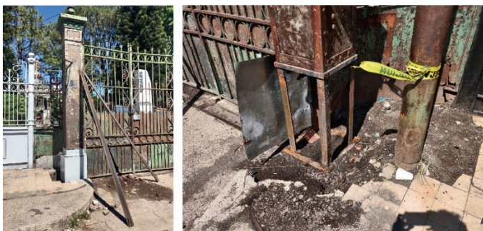
Foto 23 sustitución de la base en columnas tipo 2
