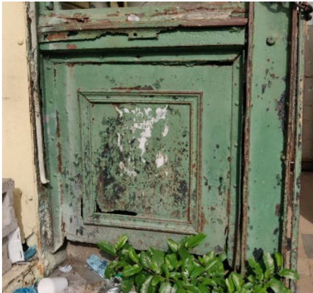
Foto 11 Parte Inferior del Barandal Hospital Rosales.
