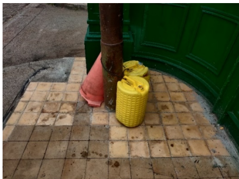
Foto 31 Estado del piso Post-Intervención
