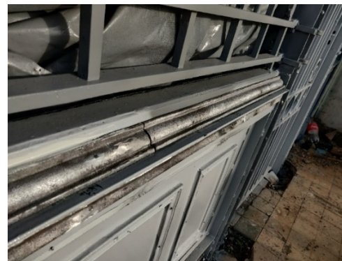
Foto 15 Parte central ya intervenida
