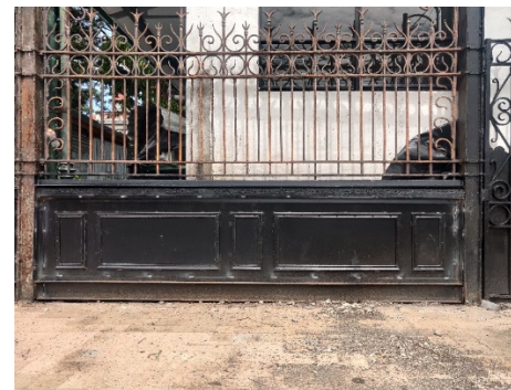
Foto 21 Parte inferior de un tramo ya reconstruido
