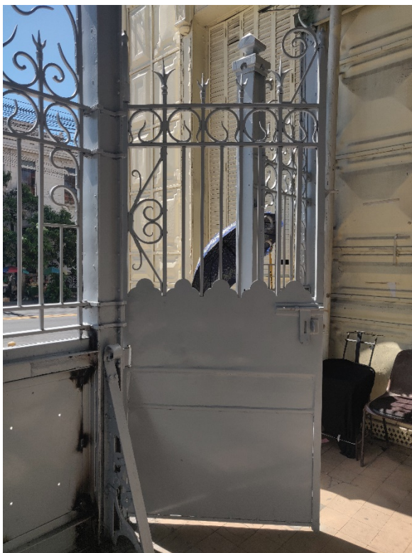
Foto 25 Puerta #1 ya intervenida
