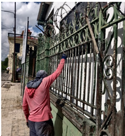
Foto 12 Remoción de pintura con espátula y removedor de pintura
