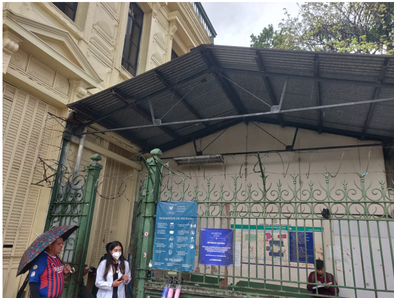
Foto 24 Vista de la Puerta 1 Único Acceso Habilitado del Barandal
