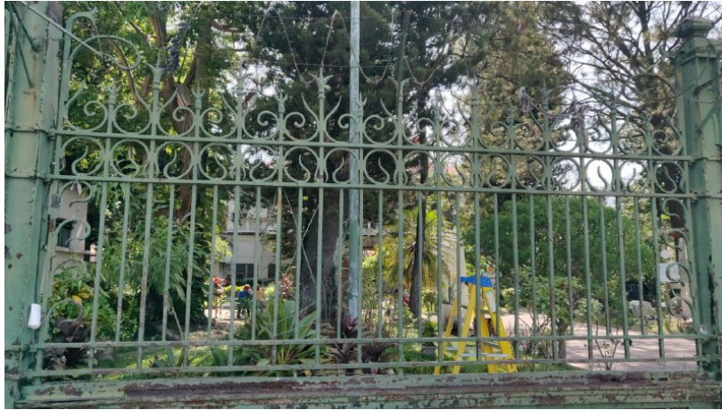
Foto 17 Parte Superior del Barandal Hospital Rosales
