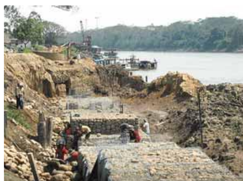
Fig. 2. 27 Relleno estructural para gaviones
