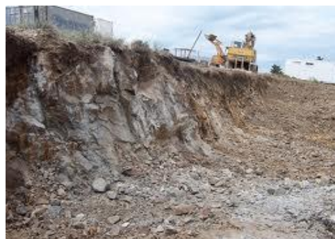
Fig. 2. 10 Excavación en roca
