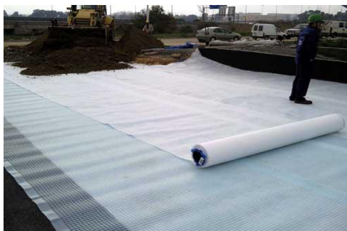
Fig. 2. 18 Colocación de Geotextil
