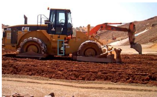
Fig. 2. 34 Colocación material subrasante
