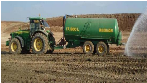
Fig. 2. 44 Humedeciendo material extendido
