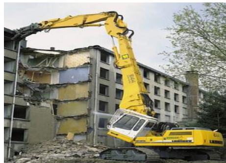
Fig. 2. 8 Eliminación de edificio
