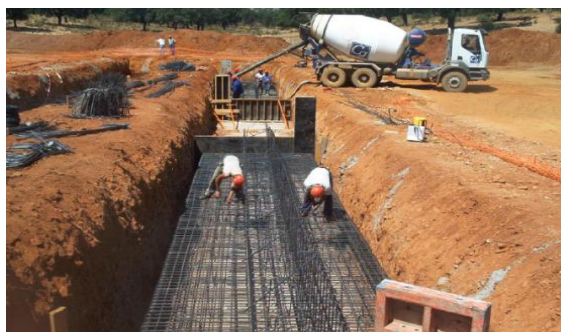
Fig. 2. 21 Excavación para estructura
