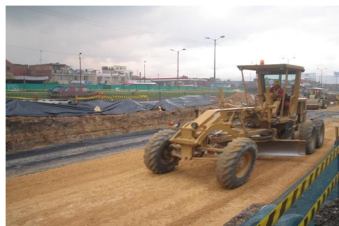
Fig. 2. 35 Conformación de subrasante
