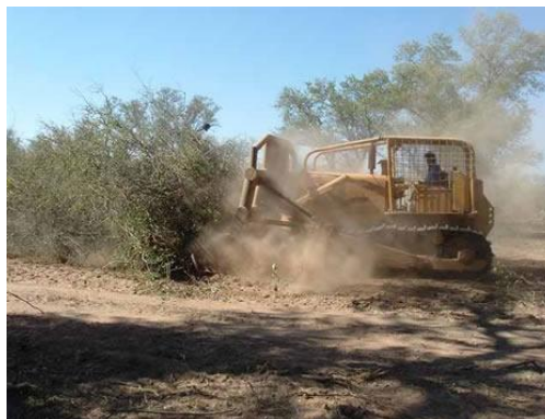
Fig. 2. 6 Eliminando capa vegetal
