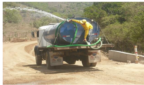
Fig. 2. 45 Humedeciendo material extendido
