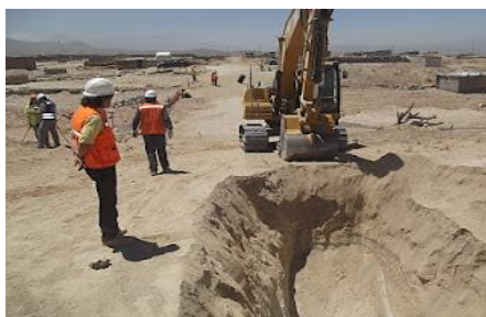
Fig. 2. 23 Excavación para alcantarillado
