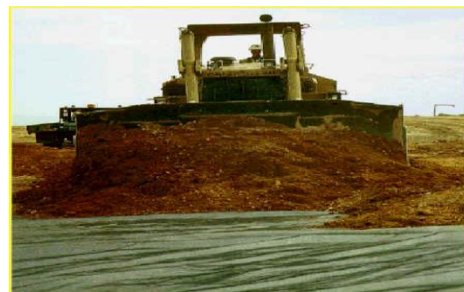
Fig. 2. 19 Recubriendo el Geotextil
