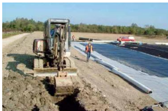
Fig. 2. 20 Geotextil colocado en carreteras
