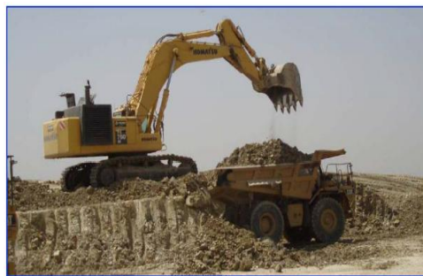
Fig. 2. 39 Carga con Retroexcavadora
