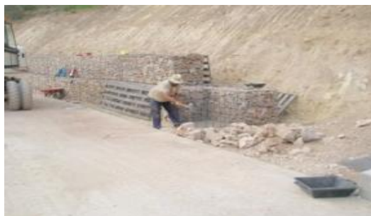
Fig. 2. 25 Colocación de gaviones en carreteras
