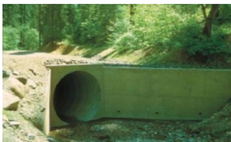
Fig. 2. 30 Rellenos para alcantarillas
