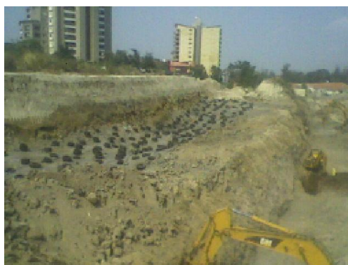
Fig. 2. 17 Removiendo roca explotada
