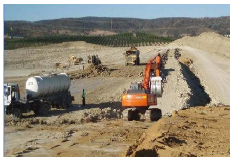
Fig. 2. 43 Extendido de material selecto
