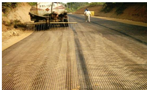
Fig. 2. 36 Estabilización de subrasante
