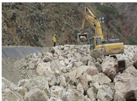
Fig. 2. 32 Construyendo pedraplen
