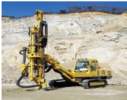
Fig. 3. 40 Perforadora Hidráulica en retroexcavadora
