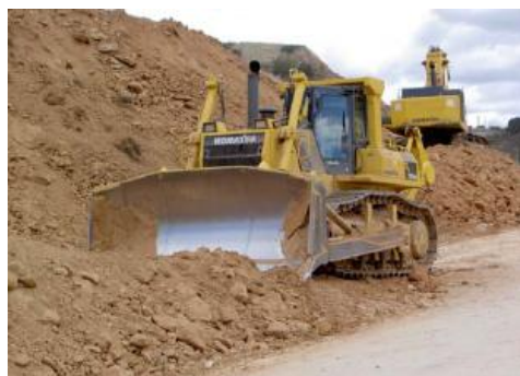
Fig. 2. 9 Excavación no clasificada
