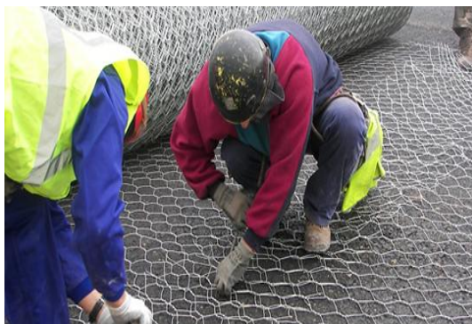
Fig. 2. 26 Construcción de gaviones
