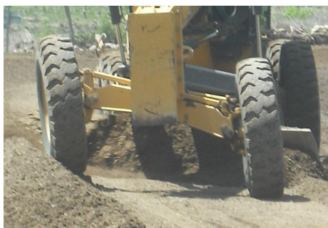
Fig. 2. 42 Homogenizando material selecto
