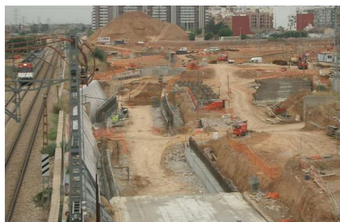
Fig. 2. 29 Relleno para bóveda
