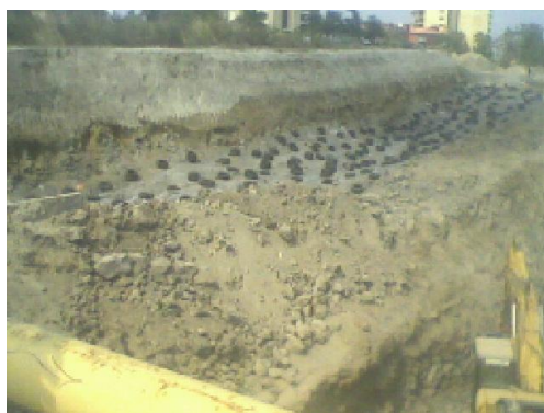
Fig. 2. 16 Colocación de explosivos
