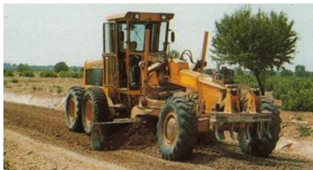
Fig. 3.37 Motoniveladora en pleno trabajo
