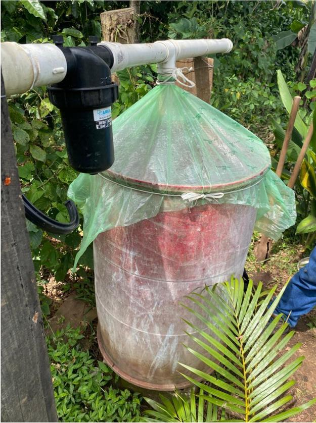
Anexo 4. Colocación de plástico sobre el barril para evitar contaminación del agua
