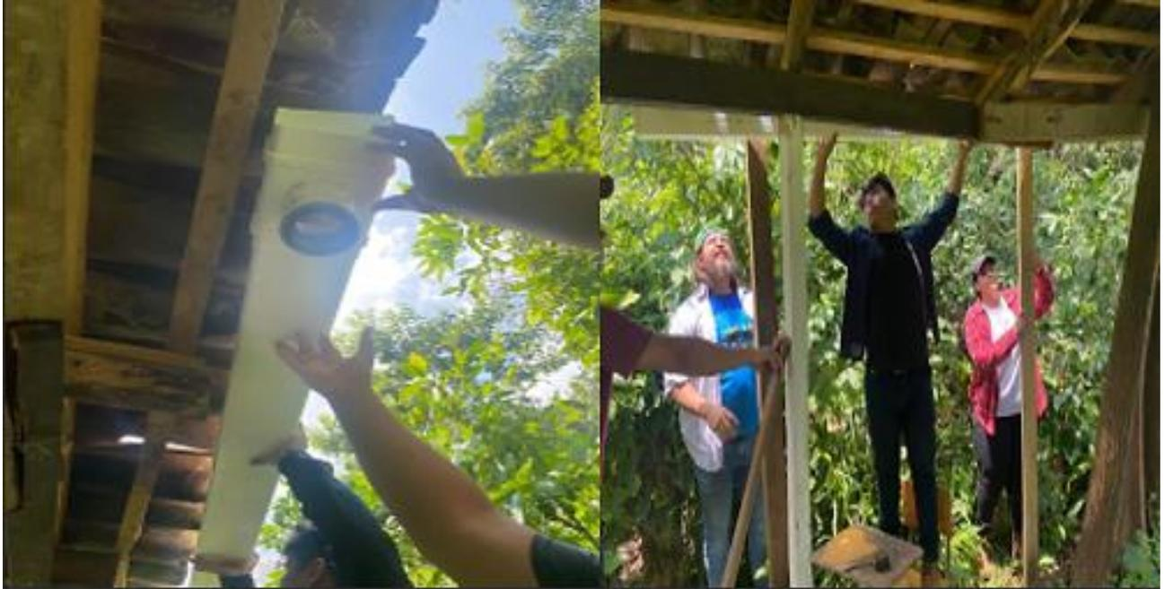
Anexo 3. Colocación del Canal liso de PVC para el sistema de cosecha de agua lluvia en Finca Flor de Lis Santa Ana.
