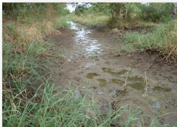
Fotografía 3.8. Estacionamiento 0 + 300, lateral izquierdo. Anegamiento de agua en un material orgánico plástico, MH. /Proporcionadas por Oficina de Información y Respuesta de Ministerio de Obras Publicas
