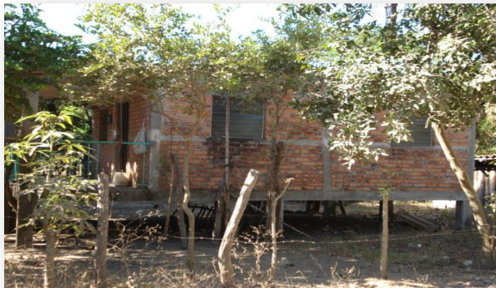
Fotografía 3. 12. Viviendas construidas sobre columnas para evitar ser inundadas durante la estación lluviosa. Proporcionadas por Oficina de Información y Respuesta de Ministerio de Obras Publicas
