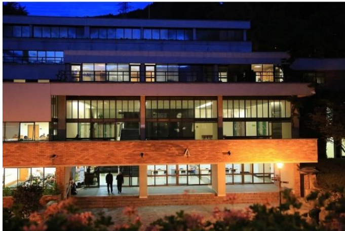
Imagen 45: Fachada edificio A
