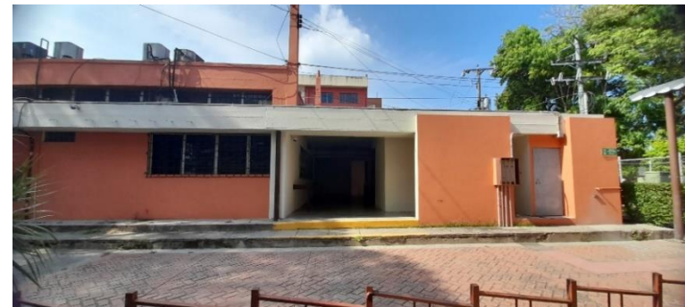
Imagen 41: Acceso desde edificio compartido
