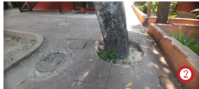
Imagen 12: Raíz levantando el piso
