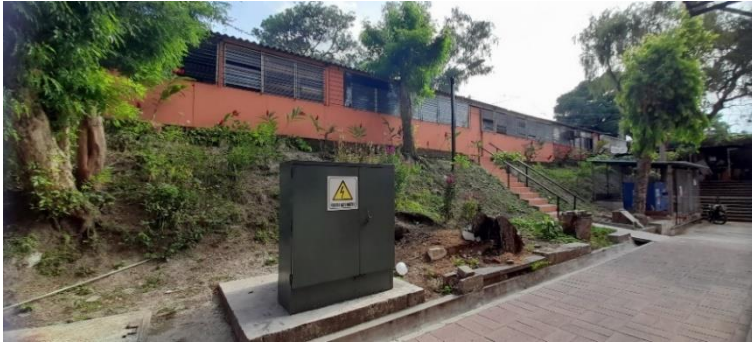
Imagen 37: Fachada posterior - edificio administración académica
