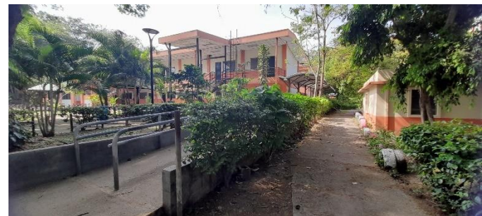
Imagen 6: Rampa de acceso desde estacionamiento.
