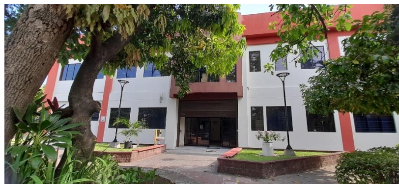
Imagen 3: Edificio Administrativo (reciente)
