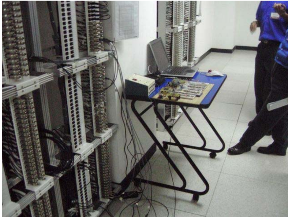
Figura 4.2. Circuito durante pruebas en las instalaciones de Digicel.
