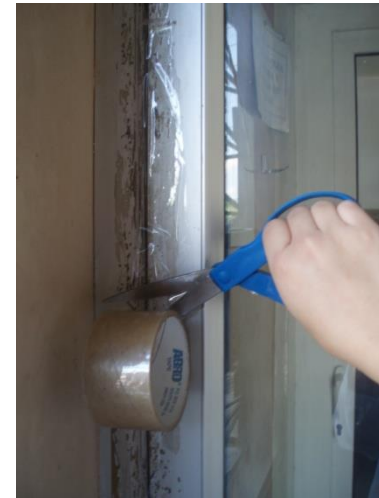
Sellado en ventanas y puertas
