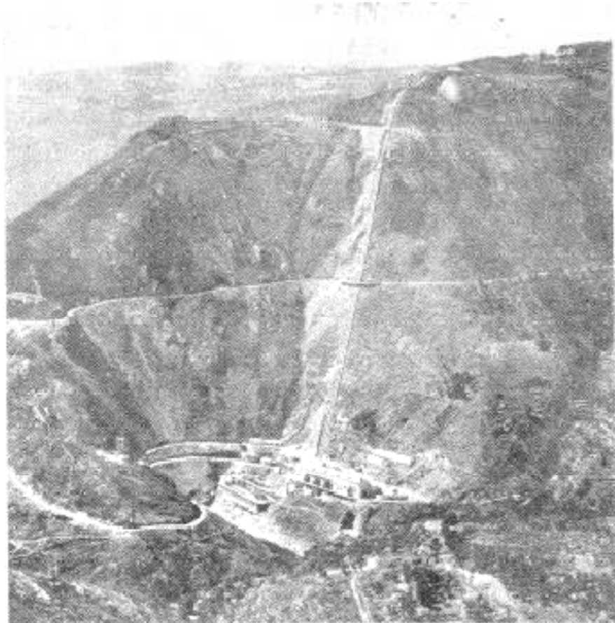
Ilustración 1.4.3: Vista aérea de la central de Pontenovo.
