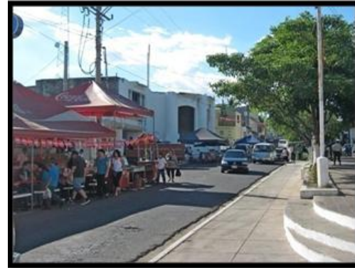
Foto 11. Vista al poniente sobre la C. Hernani Miranda Pte. En la que se observa el edificio del Palacio en ruinas.
