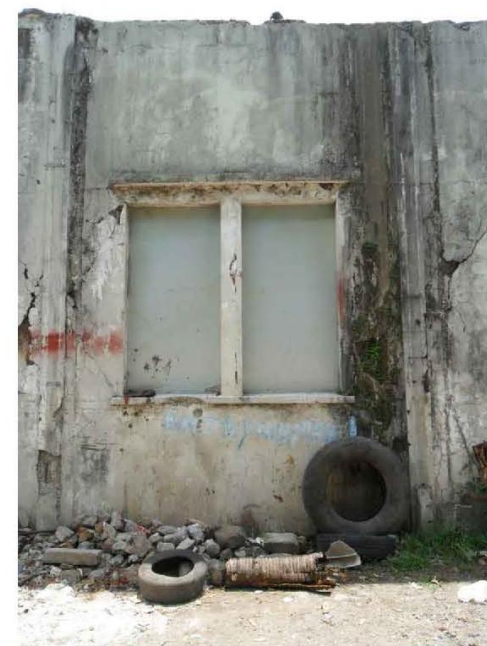
VISTA REAL CON DETALLE ACTUAL ENTRE EJES 9 & 7
