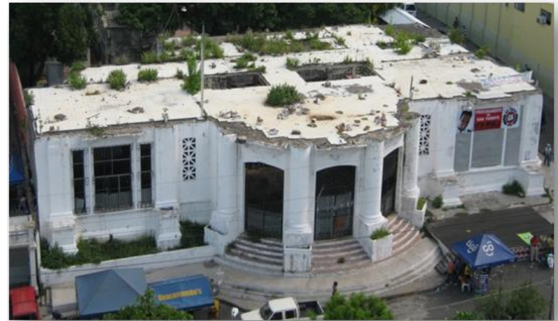
Foto 7. Estado actual del edificio
