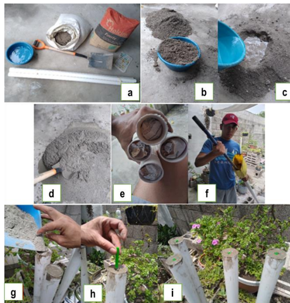
Figura A- 6. Materiales (a), cantidad de arena y cemento (b), agregar agua (c), mezcla (d), tapado de tubos de PVC (e), llenado de tubos de PVC (f) y (g), agregado de anclas (h), finalización de llenados de tubos de PVC (i)
