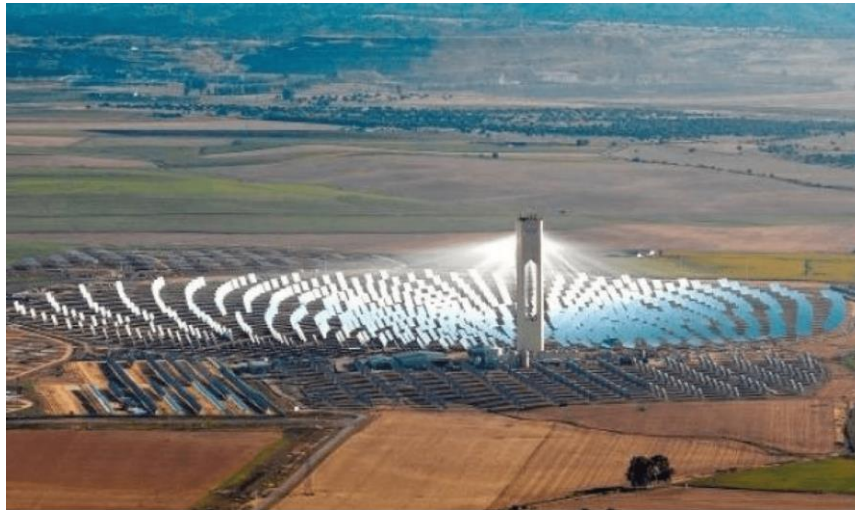
Figura 8. Central de energía solar térmica. Sevilla, España.
