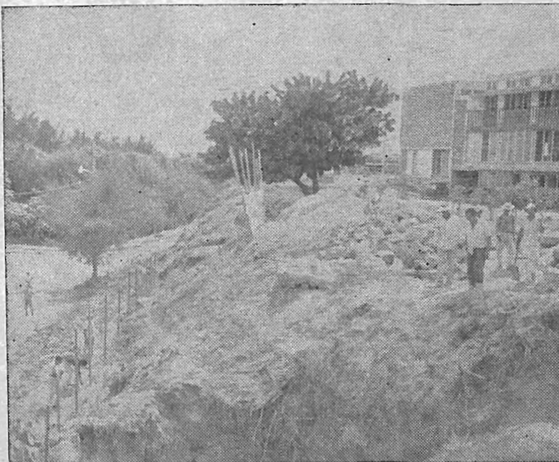
Para evitar la fuerte erosión que las lluvias torrenciales producen en la zona de residencias, se ha iniciado la construcción de un muro de grandes proporciones.
