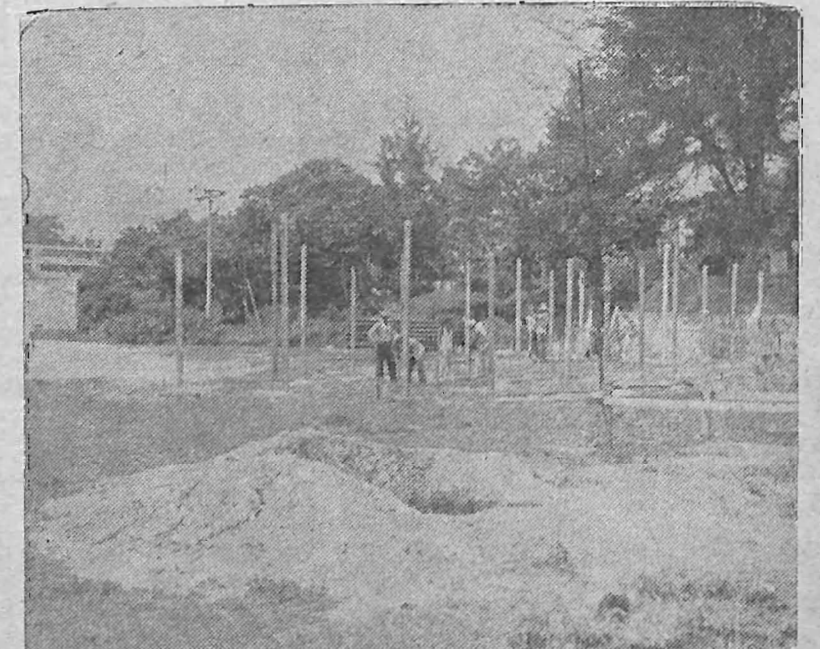
El lunes anterior fueron inaugurados los trabajos de construcción del segundo edificio de Residencias Estudiantiles, el cual estará listo a principios de mayo del 69.
