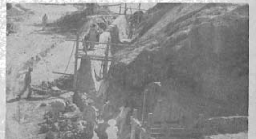
Un muro de retención de grandes proporciones se construye al norte de la Ciudad Universitaria, en las proximidades de las residencias estudiantiles. La obra será concluida pronto.
