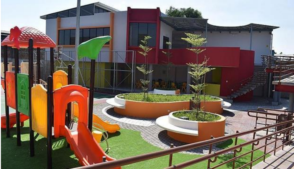
Imagen 42: Polideportivo Mauricio El Tuco Alfaro del barrio San José
