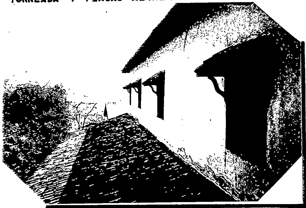
DETALLE DE VENTANAS
