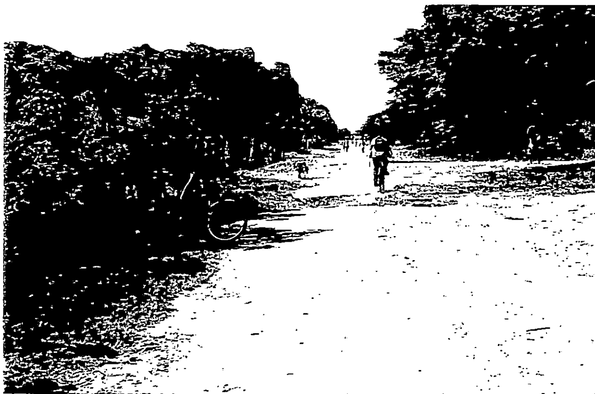
ANTIGUA CALLE A CHALATENANGO
