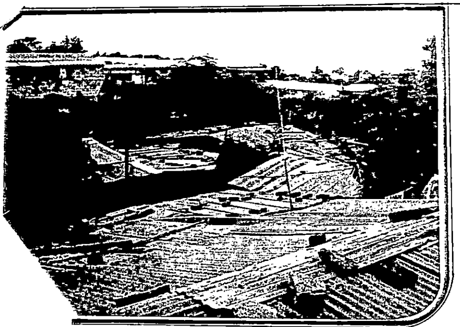
FOTO No.7 El material Predominante de la cubierta es la lámina galvanizada debido principalmente a su bajo costo y fácil instalación. Observe al fondo los condominios Montecarmelo .
