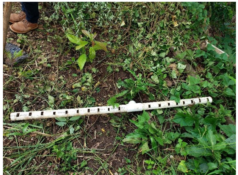
Anexo 4. Limpieza de distribuidores del humedal
