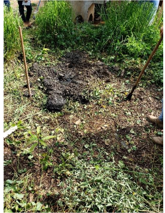
Anexo 2. Levantamiento de la lámina de grava mezclada con barro
