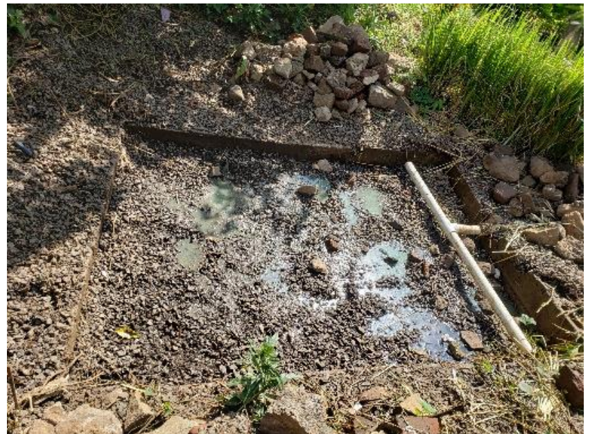
Anexo 8. Llenado del humedal artificial con grava lavada y grava nueva
