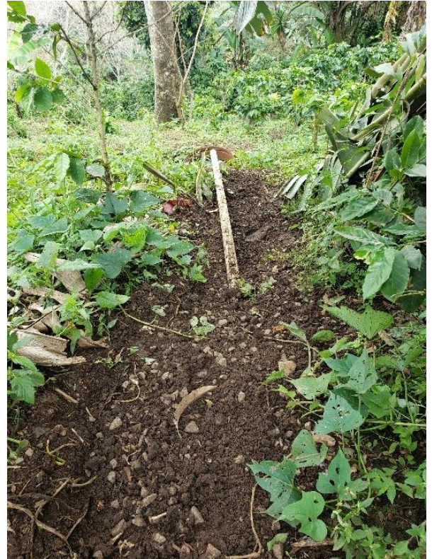
Anexo 10. Tubería de vertido reparada.
