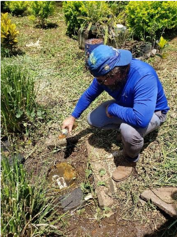
Anexo 7. Vertido de biorremediador Eficaz en la trampa de grasas
