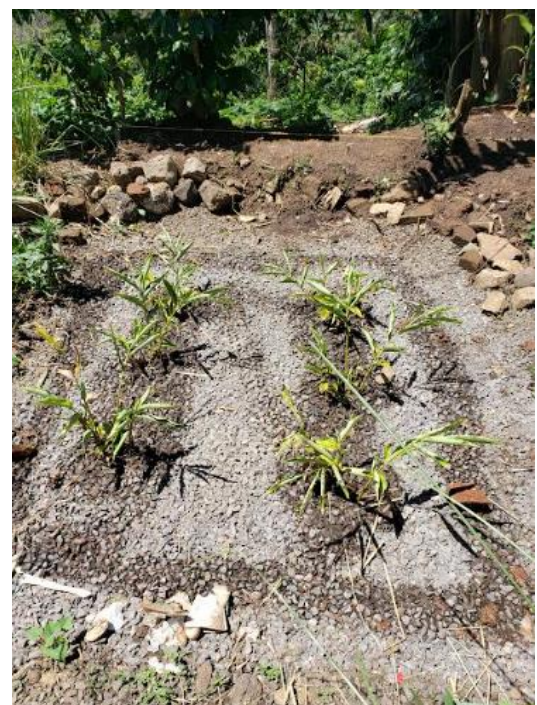
Anexo 16. Establecimiento del Humedal Artificial de Flujo Subsuperficial Horizontal.
