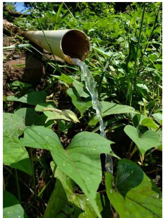
Anexo 18. Condición del agua luego del proceso de depuración por parte de Humedal Artificial de Flujo Subsuperficial Horizontal.
