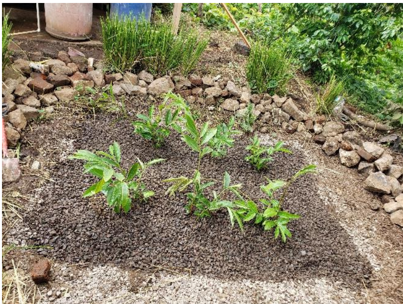
Figura 19. Humedal Artificial de Flujo Subsuperficial Horizontal posterior a las actividades de recuperación.
