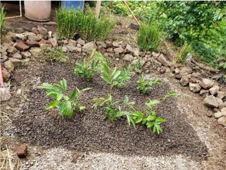
Anexo 9. Humedal artificial de flujo subsuperficial horizontal al finalizar las actividades de recuperación.
