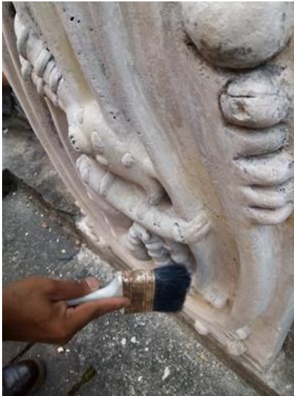
Figura 120: registro fotográfico, detalle de limpieza, vista en picada 2022. Tomada por el equipo gestor.
