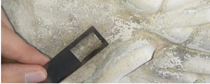
Figura 103: registro fotográfico, retiro de pintura, vista frontal 2022. Tomada por el equipo gestor.
