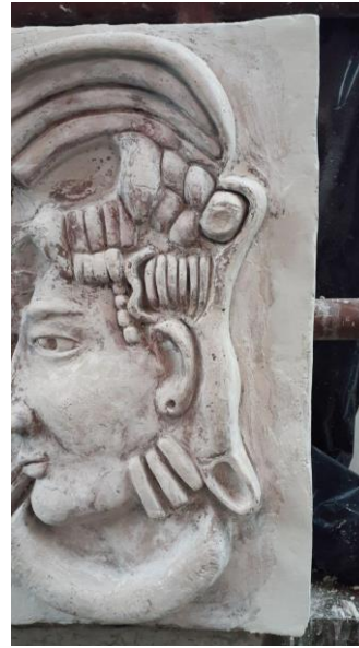
Figura 113: registro fotográfico resanado parte desprendida, vista frontal 2022. Tomada por el equipo gestor.
