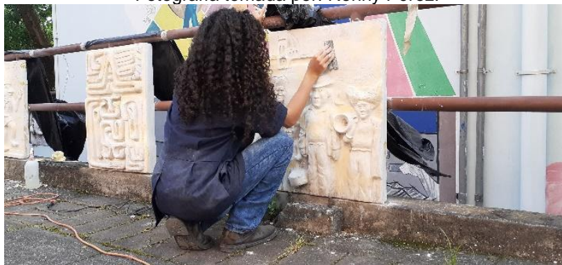
Figura 43. Proceso de lijado de forma manual, desbaste de excesos y emparejando superficies de cada relieve.
