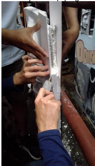
Figura 110: registro fotográfico, colocación de cimbras, vista lateral 2022. Tomada por el equipo gestor.
