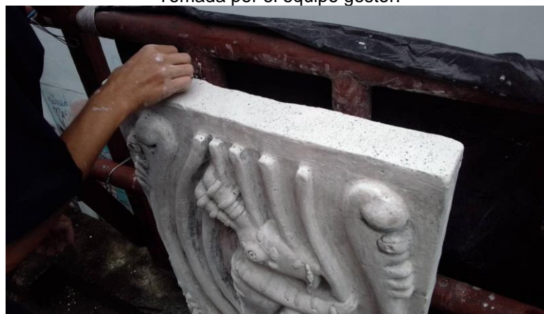
Figura 115: registro fotográfico, alisado de lateral con esponja, vista en picada 2022. Tomada por el equipo gestor.
