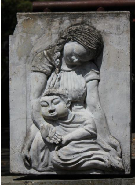
Figura 61: relieve N° 1, registro del estado físico encontrado, vista frontal 2022. Fotografía tomada por equipo gestor.
