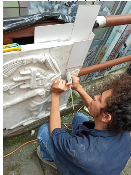
Figura 111: registro fotográfico, colocación de cimbras, vista en picada 2022. Tomada por el equipo gestor.
