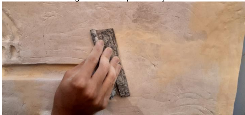
Figura 42. Detalle proceso de lijado de forma manual, desbaste de excesos y emparejando superficies de cada relieve.
