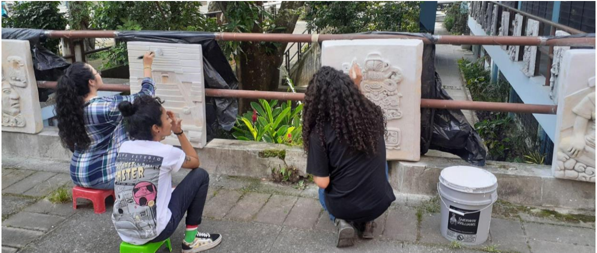
Figura 50. Proceso general de aplicación de impermeabilizante aqualock blanco. Participación de estudiantes de la opción de pintura: Grecia Mejía, Karen Guandique. Fotografía tomada por: Carlos Cubias.
