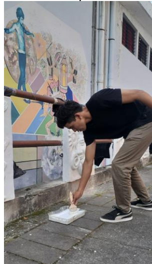
Figura 51. Proceso final, aplicación de impermeabilizante aqualock blanco, Lic. Ernesto Guzmán. Fotografía tomada por: Carlos Cubias.
