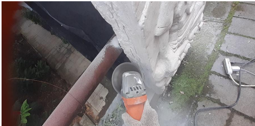
Figura 31. Uso de esmeril angular para el trazado general de sisas en lado izquierdo del relieve. Fotografía tomada por: Ronny Pérez.
