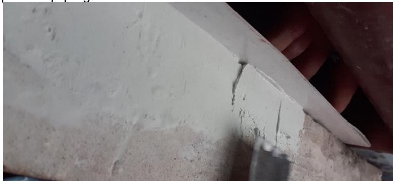
Figura 114: registro fotográfico aplicación de mezcla para resanado de laterales, vista en picada 2022. Tomada por el equipo gestor.
