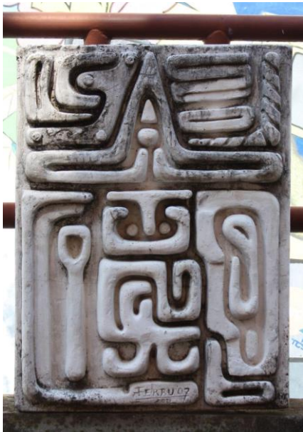
Figura 79: relieve N° 10, registro del estado físico encontrado, vista frontal 2022. Fotografía tomada por equipo gestor.
