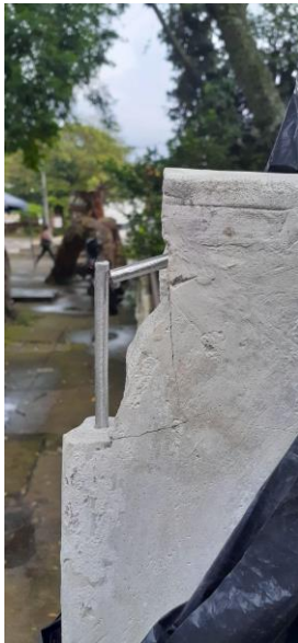
Figura 108: registro fotográfico, instalación de pines metálicos, vista frontal 2022. Tomada por el equipo gestor.
