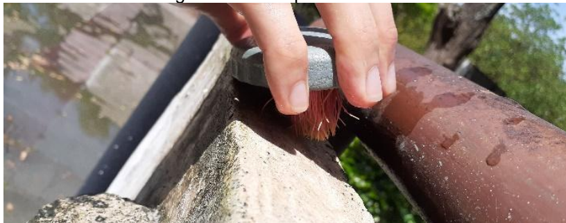
Figura 22. Detalle, uso de cepillo para tratar aspectos carácter biológicos en relieves. Fotografía tomada por: Ronny Pérez.
