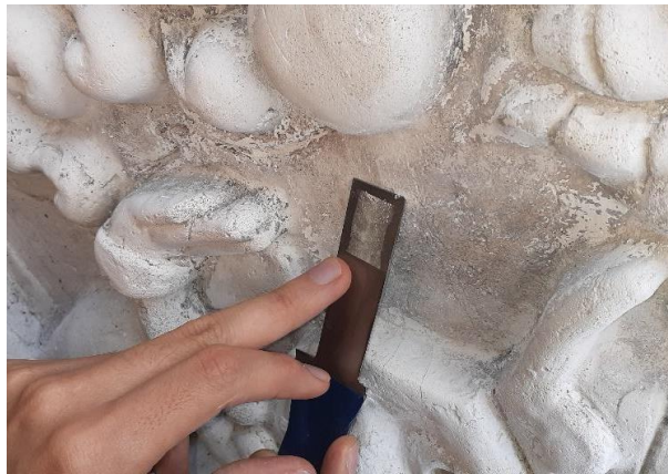
Figura 28. Detalle, uso de espátula para retirar capas de pintura en relieves. Fotografía tomada por: Ronny Pérez.
