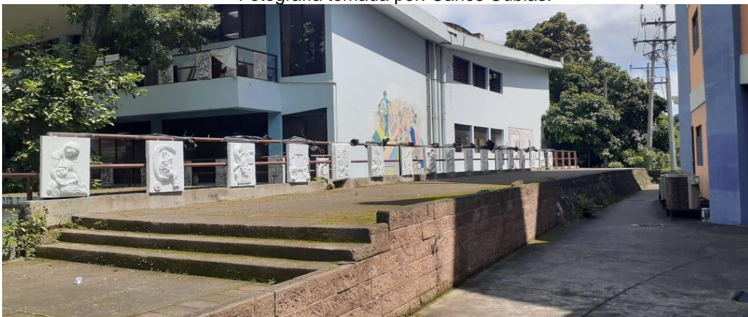
Figura 52. Proceso final de relieves con impermeabilizante aqualock blanco aplicado, vista lateral izquierdo. Fotografía tomada por: Ronny Pérez.
