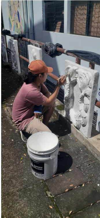
Figura 124: registro fotográfico, aplicación de impermeabilizante, vista \frac{3}{4} 2022. Tomada por el equipo gestor.
