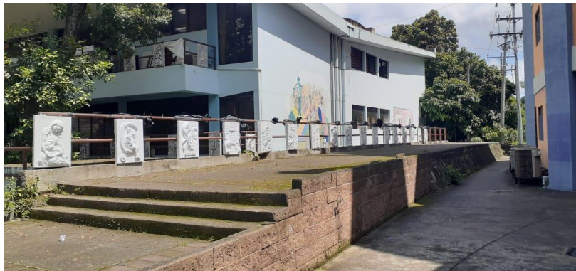
Figura 126: registro fotográfico, plano general, vista \frac{3}{4} 2022. Tomada por el equipo gestor.
