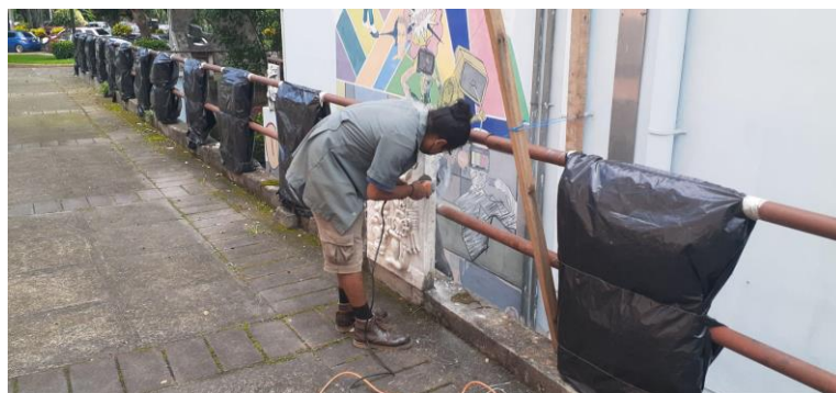
Figura 101: registro fotográfico, retiro de pintura, vista frontal 2022. Tomada por el equipo gestor.
