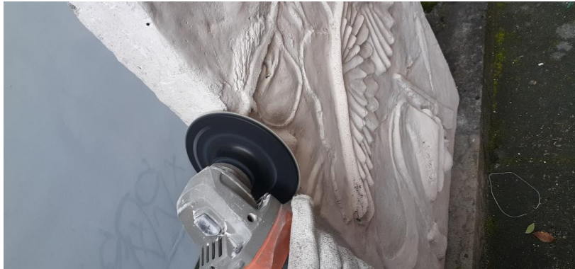
Figura 41. Proceso de lijado, se nivelaron las caras laterales de cada relieve con el uso del esmeril angular.
