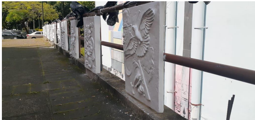
Figura 128: registro fotográfico, a detalle 2022. Tomada por el equipo gestor.
