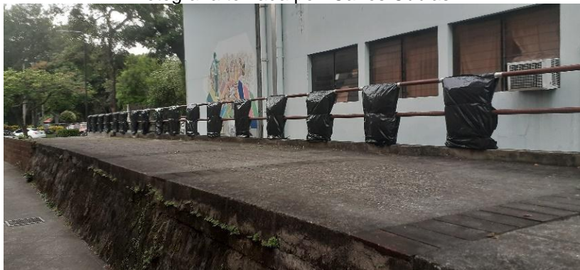
Figura 27. Protección de relieves de forma individual, para evitar acumulación de humedad y evitar mayor deterioro. Fotografía tomada por: Ronny Pérez.
