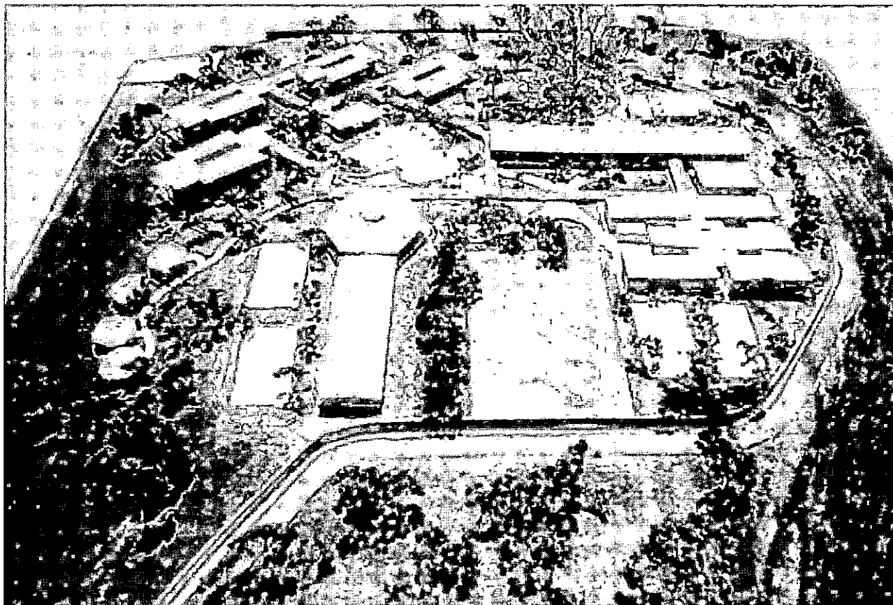
VISTA DEL CONJUNTO HACIA EL SUR
