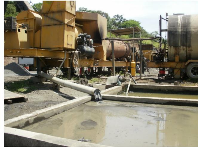
*Figura 104: Lechada del lavado de maquinaria de concreto hidráulico Fuente: Dirección Implementadora de Proyectos de Infraestructura Logística (DIPIL), MOP.*
