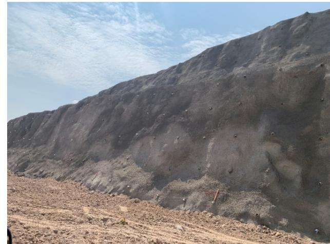
*Figura 95: Barbacanas en Talud de concreto lanzado, By Pass San Miguel
