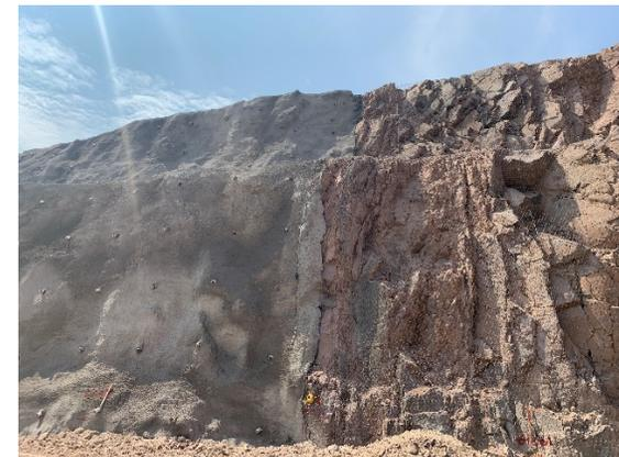
**Figura 99: Revestimiento de concreto lanzado en Talud, By Pass San Miguel**
