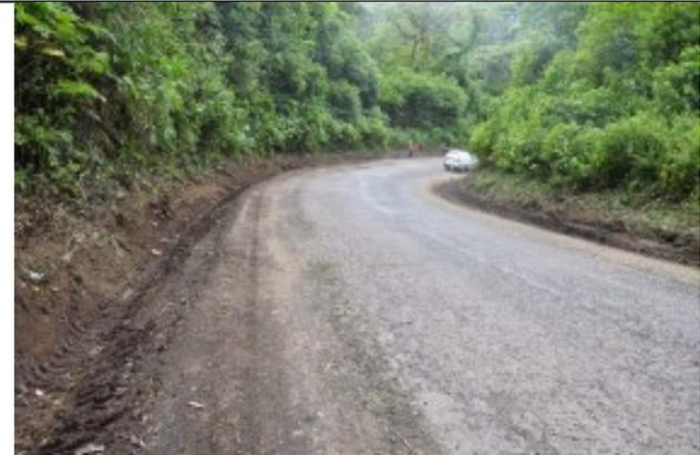
*Figura 79: Ejemplo de cunetas conformadas en el terreno de manera provisional.*
