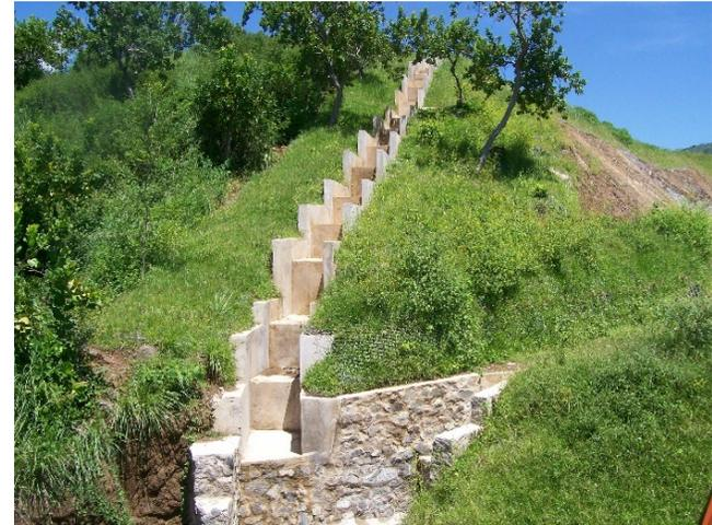
*Figura 91: Drenaje superficial, disipadores Fuente: Direccion Implementadora de Proyectos de Infraestructura Logística (DIPIL), MOP*
