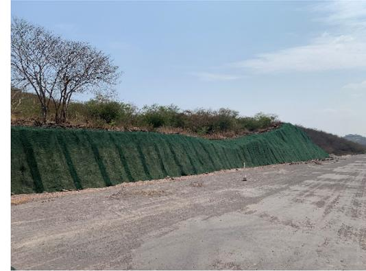
*Figura 100: Revestimiento de Geotextil en Talud By Pass San Miguel*
