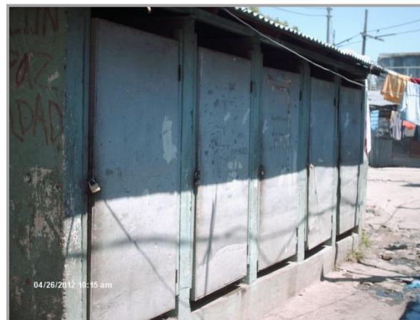
Ilustración I-10. Servicios Sanitarios colectivos. Foto propia.
