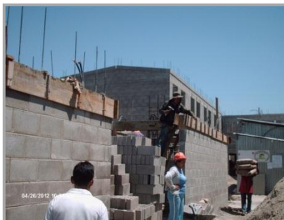
Ilustración 13. Proceso de construcción complejo habitacional ACOVIVAMSE. Foto propia.
