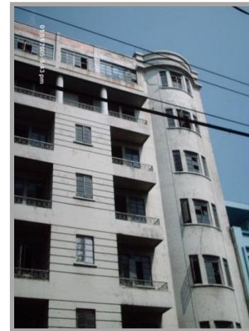
Ilustración I-1. Fachada Edificio Regalado. Foto propia
