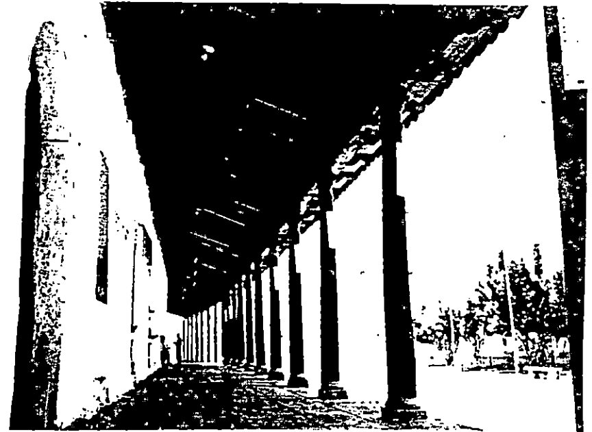
PORTAL NORTE DE PLAZA CENTRAL
