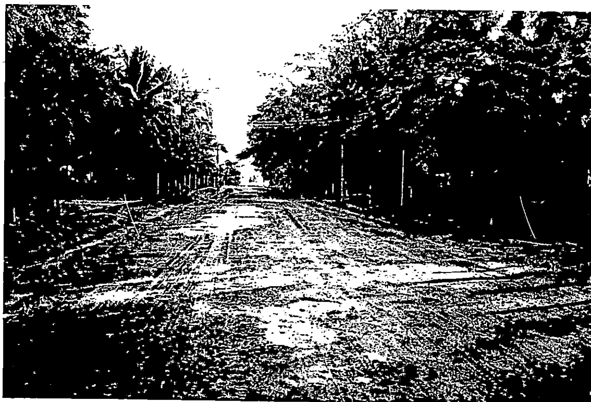
CALLE A EL TAMARINDO . Vista hacia el cantón El Tamarindo , Punta Jagüey . Calle de superficie de tierra , de forma casi plana y carece de drenajes , lo que provoca estancamientos de agua en el invierno .
