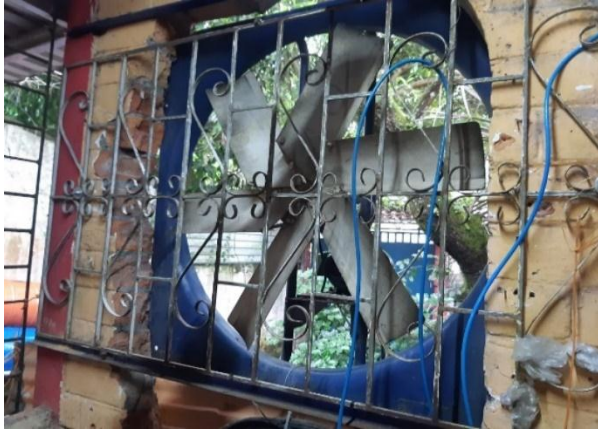
El sistema de ventilación está compuesto por dos ventiladores industriales.
