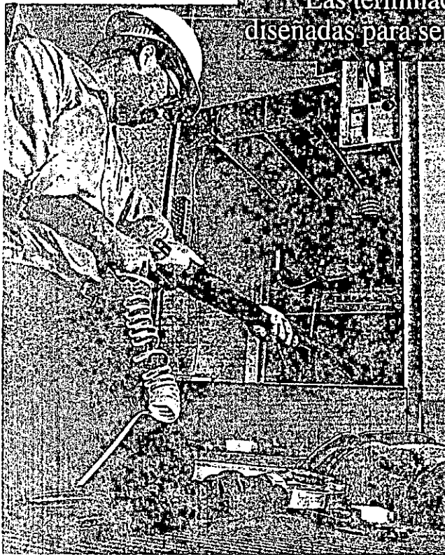
Cold Shrink™ QT-III Terminaciones para Interiores.
