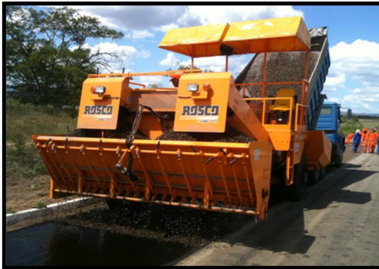
**Figura 3.8 Proceso de distribución de Agregado**
