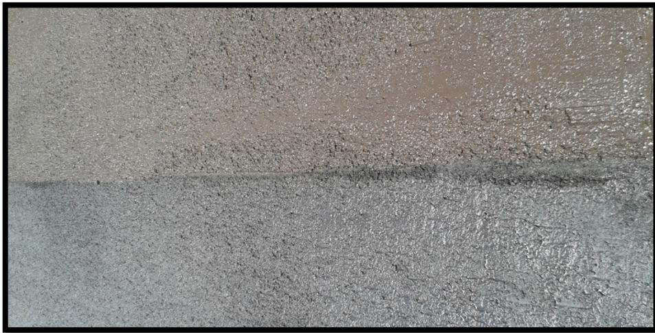
**Fotografía 3.5 Micropavimento recién colocado se pueden observar la coloración marrón previa a la ruptura y el color negro posterior a la ruptura**
