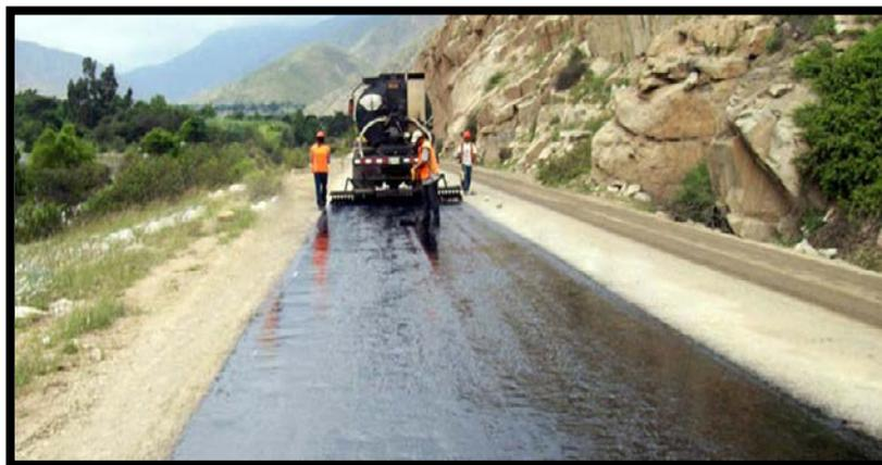
Figura 3.6 Aplicación de Asfalto sobre Base Granular
