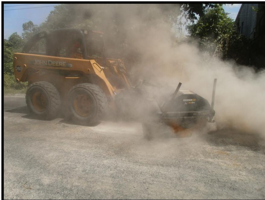
**Fotografía 3.8 Proceso de barrido para preparación de la superficie**
