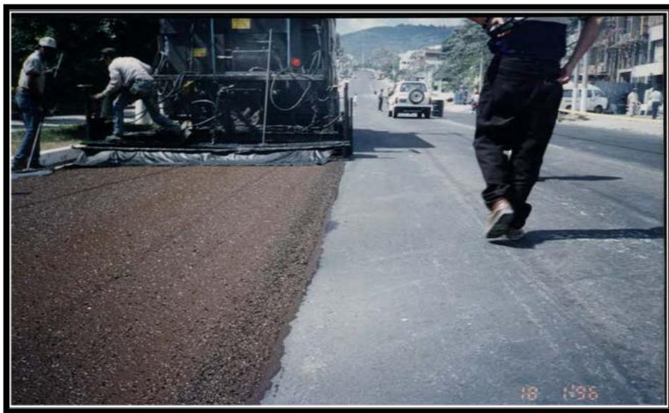
**Fotografía 1.2 Aplicación de Micropavimento sobre el Paseo General Escalón, 1996**
