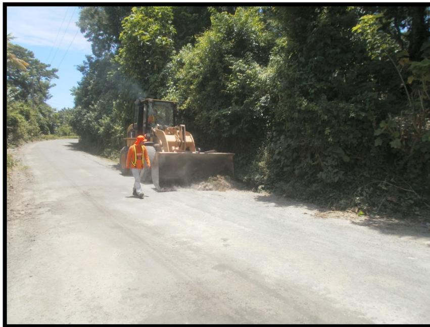
**Fotografía 3.7 Limpieza de material suelto en la superficie**
