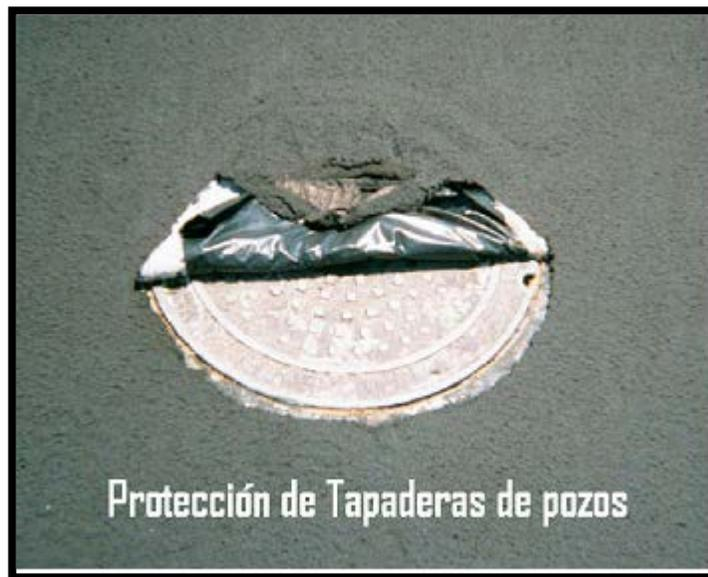
**Figura 3.14 Protección de tapaderas de pozos o válvulas de agua**
