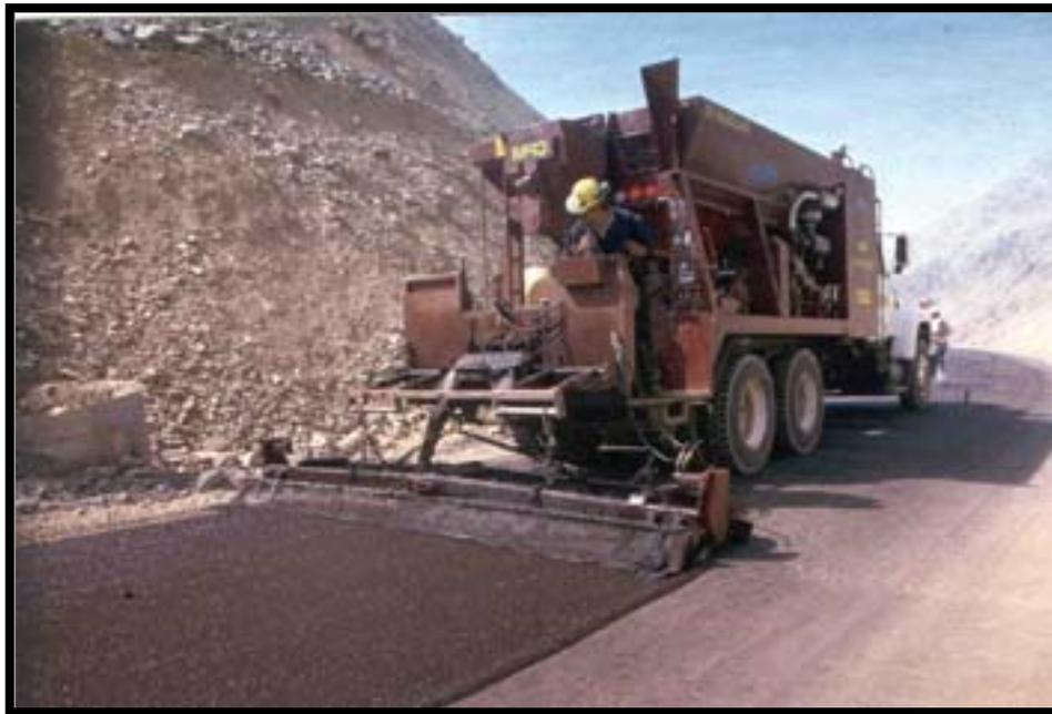
**Figura 3.7 Esparcido del Asfalto Sobre Base Tratada**
