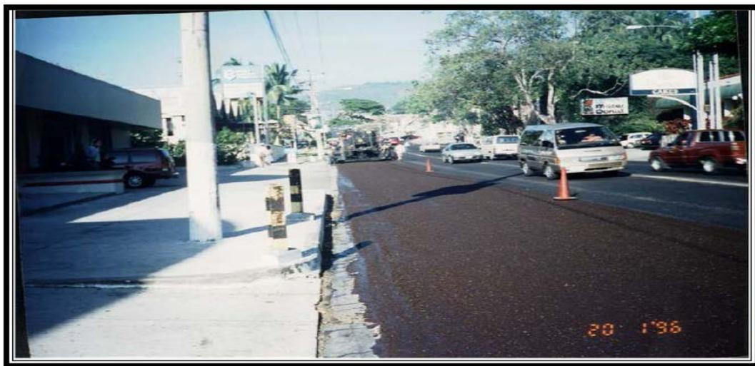
**Fotografía 1.1 Aplicación de Micropavimento sobre el Paseo General Escalón, 1996**
