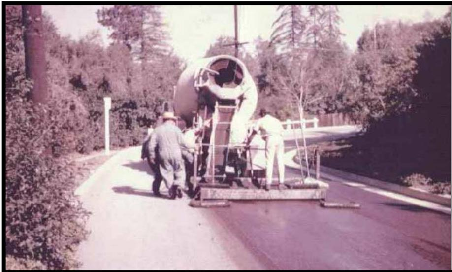
**Figura 1.2 Primeros modelos de máquinas aplicadoras de Slurry Seal<sup>2</sup>**
