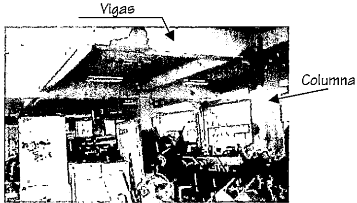
Foto No. 9 Detalle de daños en Vigas y Columnas
