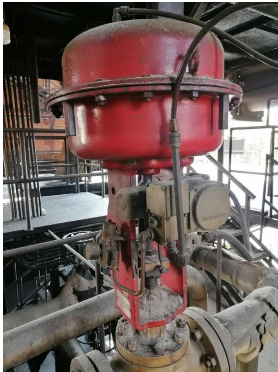
Figura 42. Actuador Masoneilan para válvula de retorno de 3"
