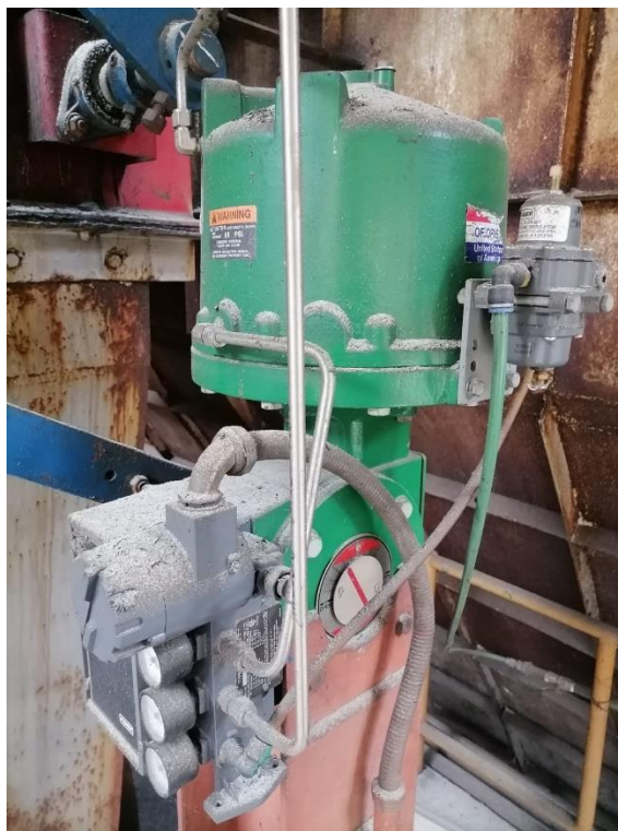
Figura 41. Actuador Fisher para damper de tiro inducido
