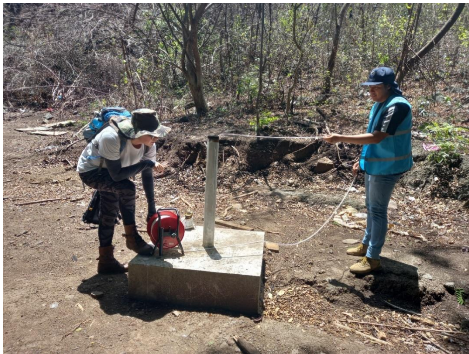
Medición de profundidad nivel estático de pozo de monitoreo en las instalaciones del Relleno Sanitario de Santa Ana.
