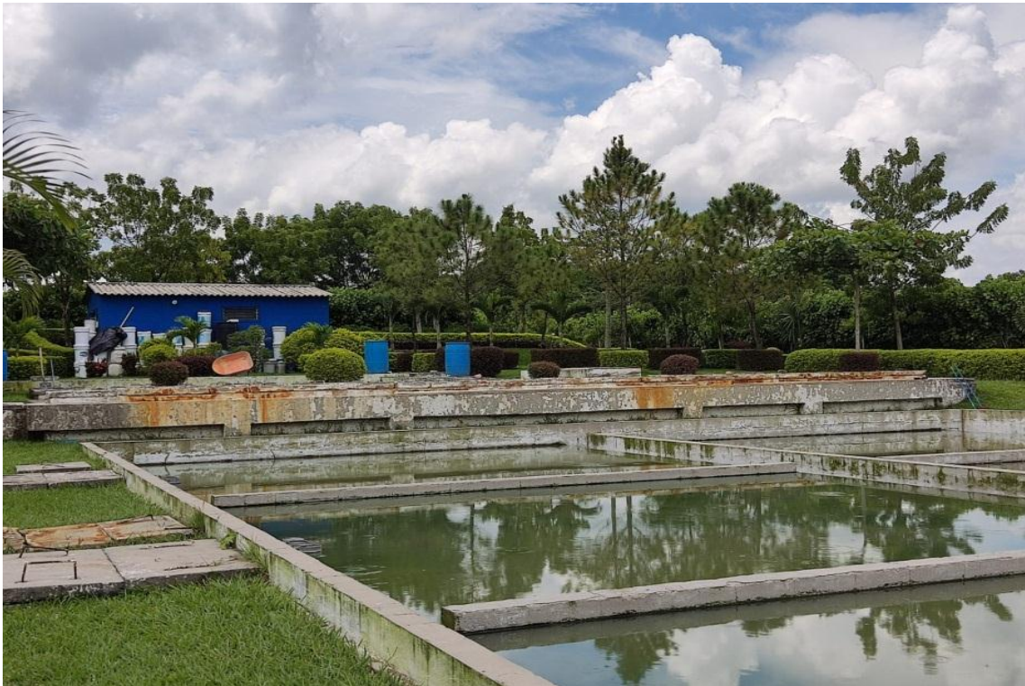
Figura A8: Filtros Anaeróbicos de Flujo Ascendente.
