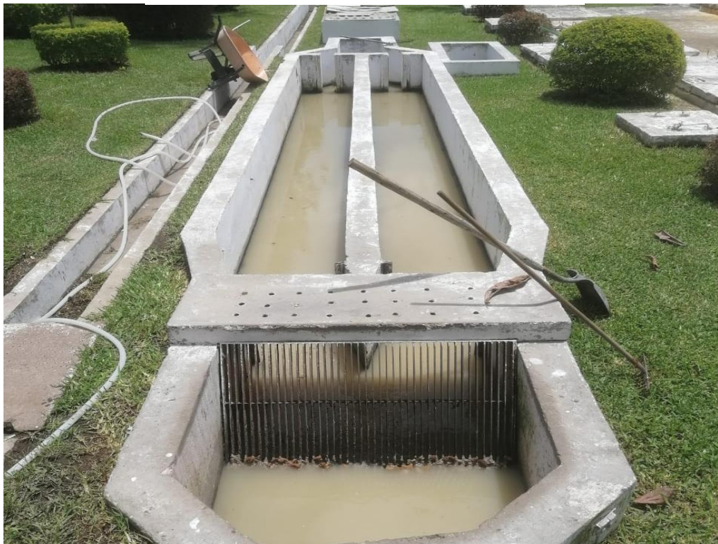
Figura A7: Desarenador.
