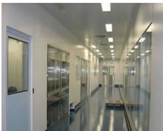
Figura N<sup>o</sup> 6: Techo epóxico y luces empotradas.
