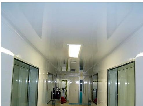
Figura N<sup>o</sup> 3: techo epóxico liso.
