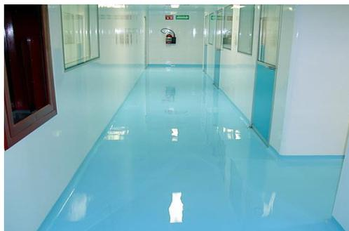
Figura N<sup>o</sup> 1: Piso epóxico con bordes redondeados.
