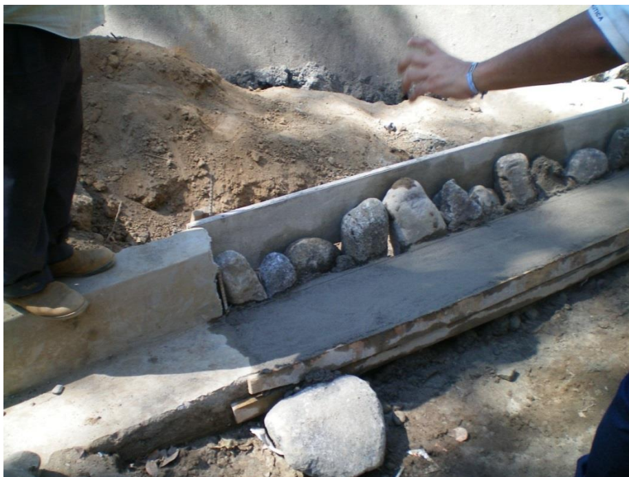
Figura 3.8: CUNETAS EMPEDRADAS
