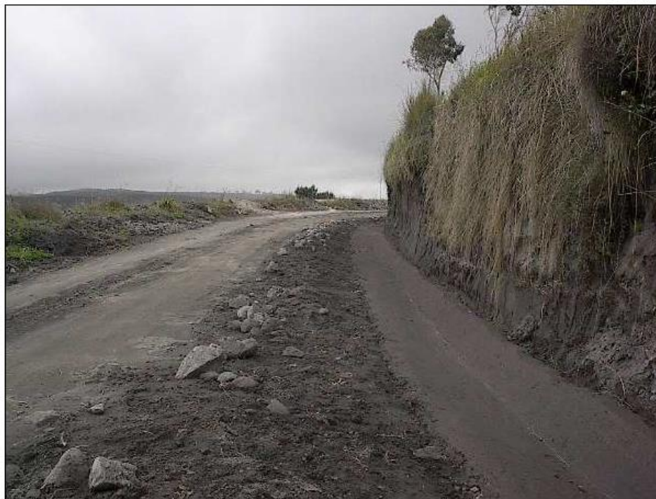
Figura 3.9: CUNETA TERMINADA
