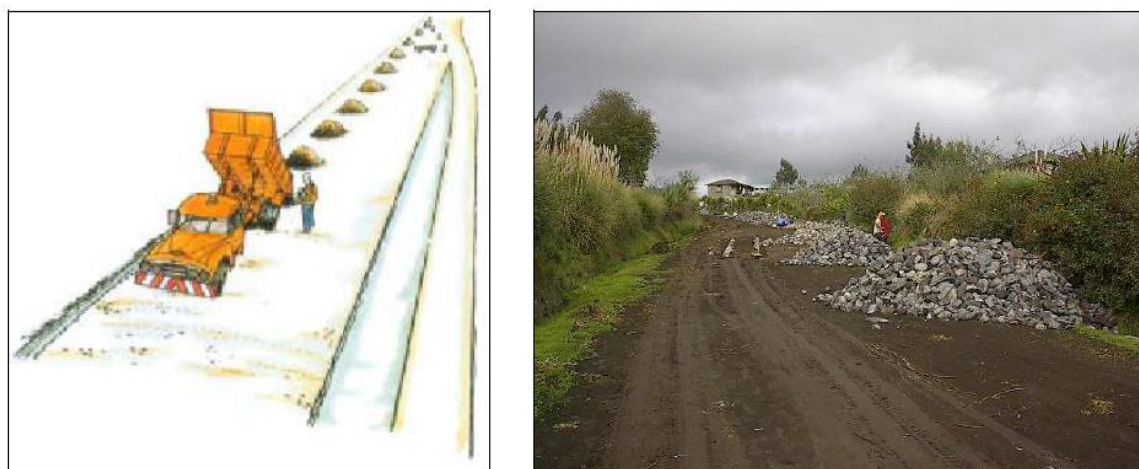
Figura 3.5: TRANSPORTE Y ACOPIO DE MATERIAL
