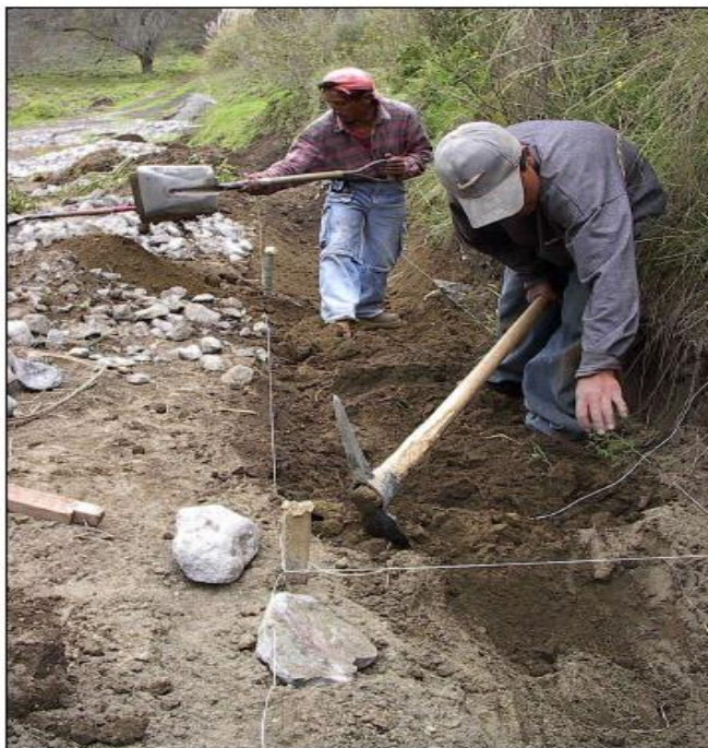
Figura 3.6: CONFORMACION DE LA CUNETETA
