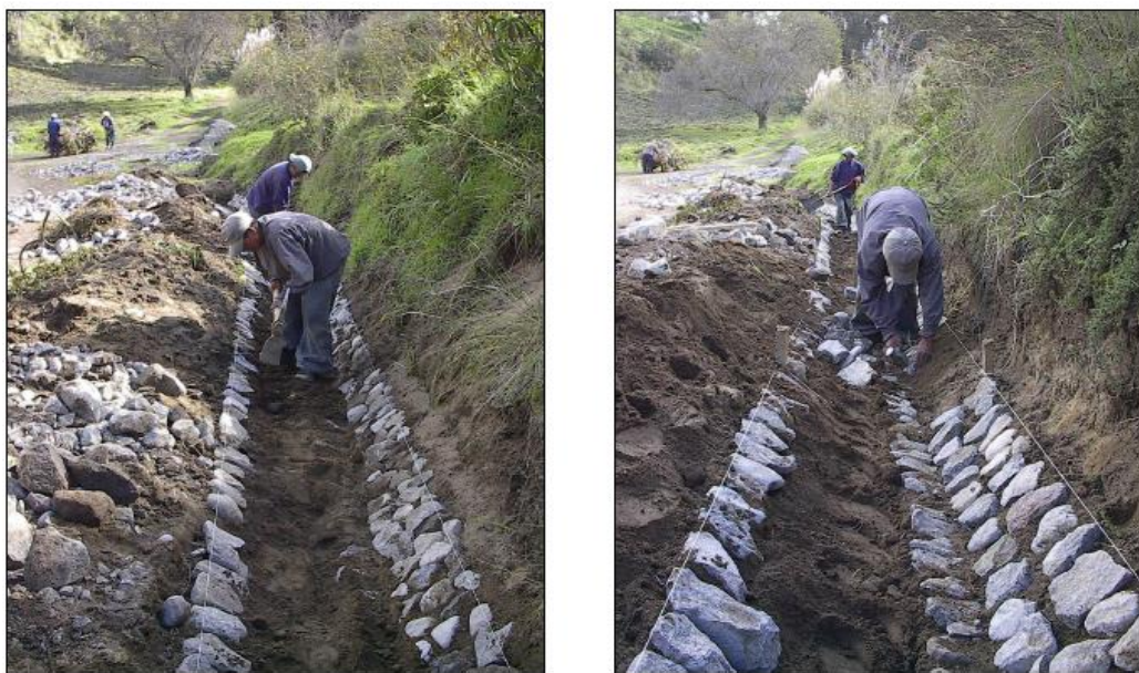
Figura 3.7: COLOCACION DE LA PIEDRA EN CUNETAS
