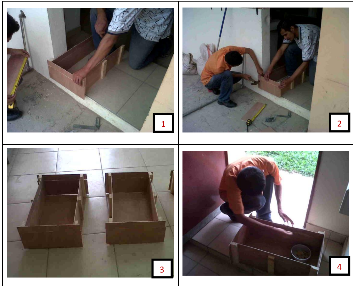
Figura 4.3: ELABORACION DE MOLDES DE VIGA MODIFICADA
